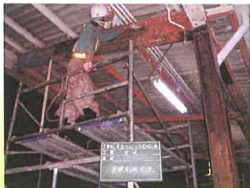
剥離剤によるはく離実施例
