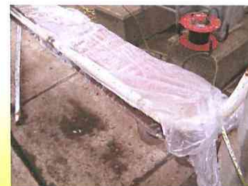
剥離剤によるはく離実施例
