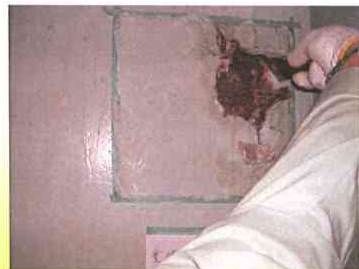
剥離剤によるはく離実施例
