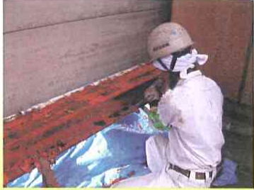
剥離剤によるはく離実施例
