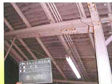
剥離剤によるはく離実施例
