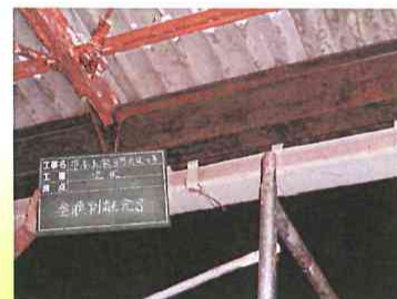
剥離剤によるはく離実施例
