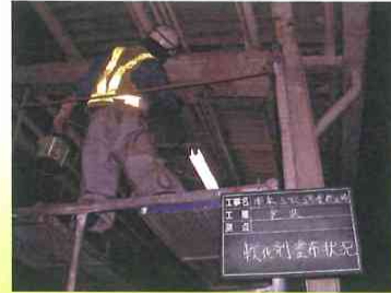
剥離剤によるはく離実施例
