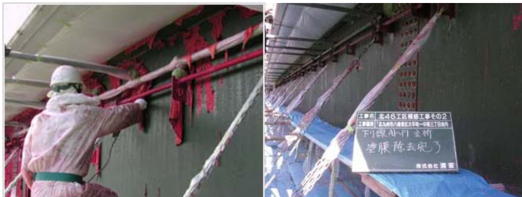
写真-5 塗膜除去状況
