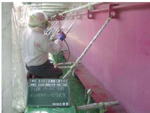
写真-4 エアレススプレーによる塗付
