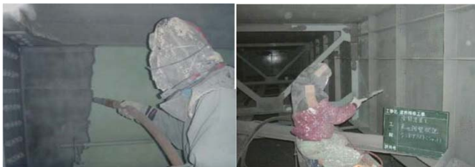
写真-1 ブラスト工法作業状況
