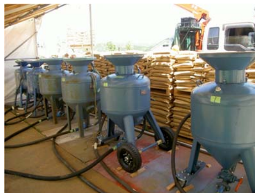
写真-5 ブラスト機材の設置状況
