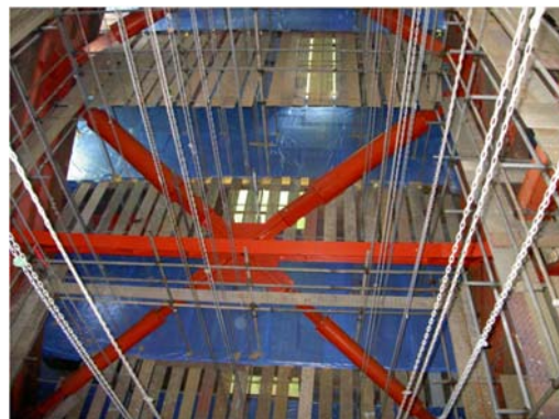
写真-3 チェーンと足場の状態
