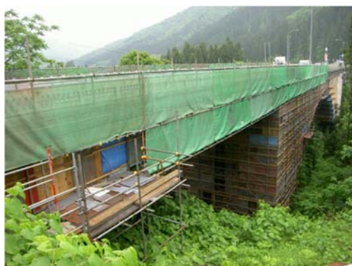
写真-4 防護状況
