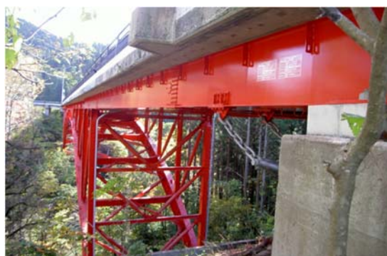
写真-1 対象橋梁
