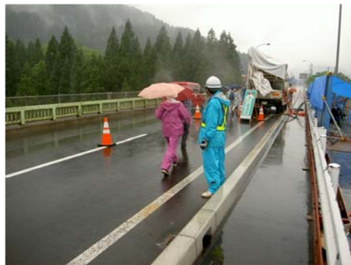
写真-11 通行誘導状況
