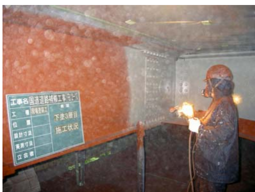
写真-8 スプレー塗装状況
