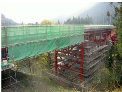
写真-2 足場架設状況
