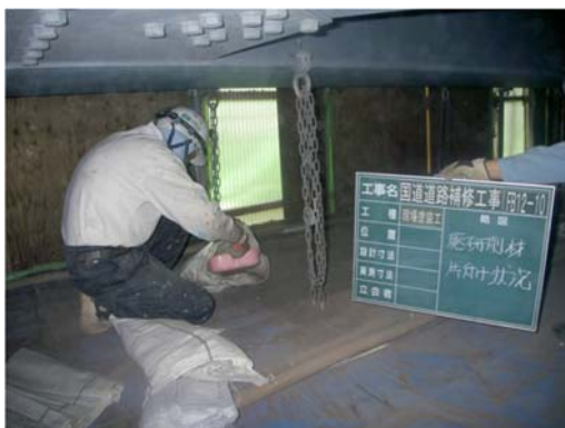
写真-6 廃研削材の片付け状況
