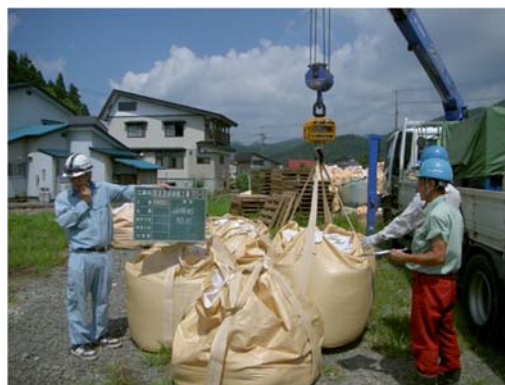
写真-7 廃研削材の処分運搬状況
