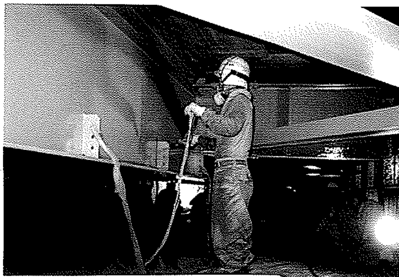
高塗着スプレーの 実橋塗装状況
