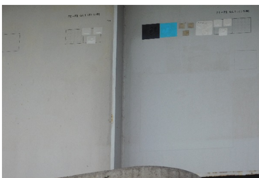
写真-11 塗装状況 （リブ境に左は有機塗装・右は無機塗装）
