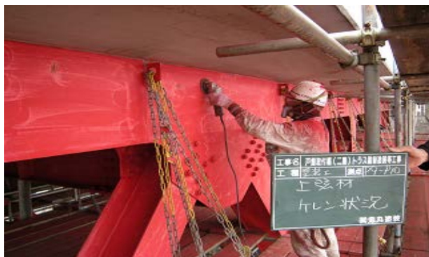
写真-4 ケレン状況 (アンカーパターン作成)
