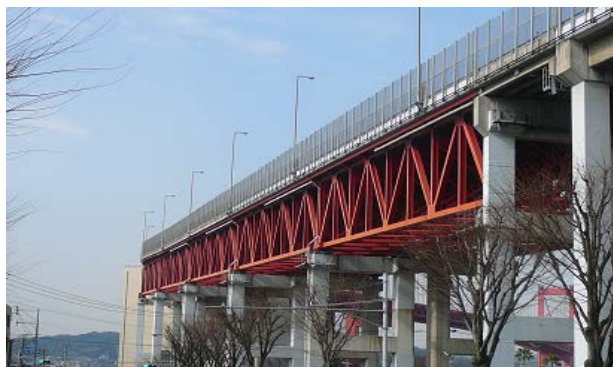
写真-2 戸畑トラス高架橋 (L=244m)
