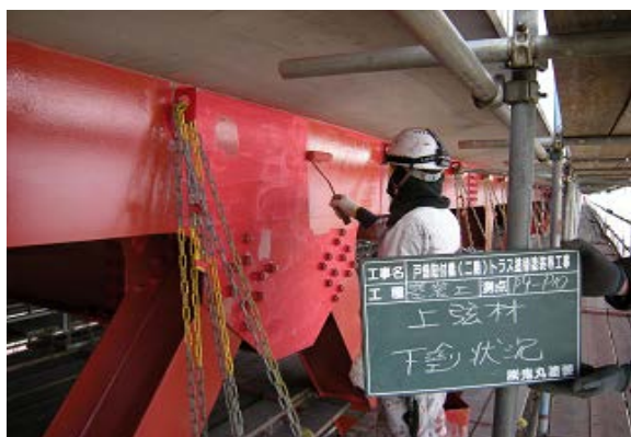
写真-6 下塗り状況
