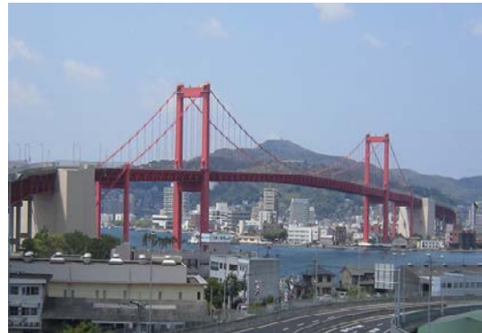
写真-1 建設 56 年経過した若戸大橋
