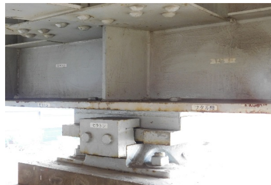
写真-12 塗装状況 （リブ境に左は無機塗装・右は有機塗装）
