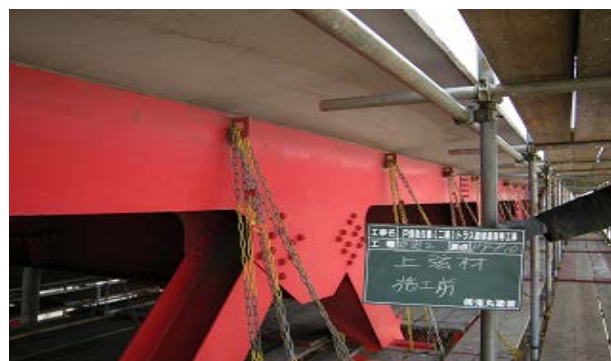
写真-3 施工前状況
