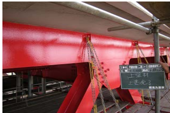
写真-9 塗替え塗装完成 (光沢度極めて高い)
