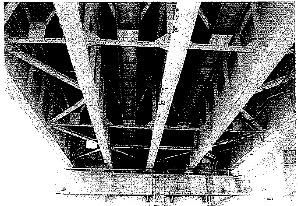
北郷高架橋 試験施工場所
