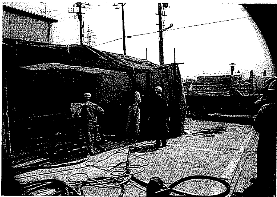
ガーネットによるモイスターブラスト 噴射水圧 : 0.3MP a 噴射水量 : 0.24L/分 ブラスト吐出圧力 : 0.6MP a ブラストノズル : 10mm φ
