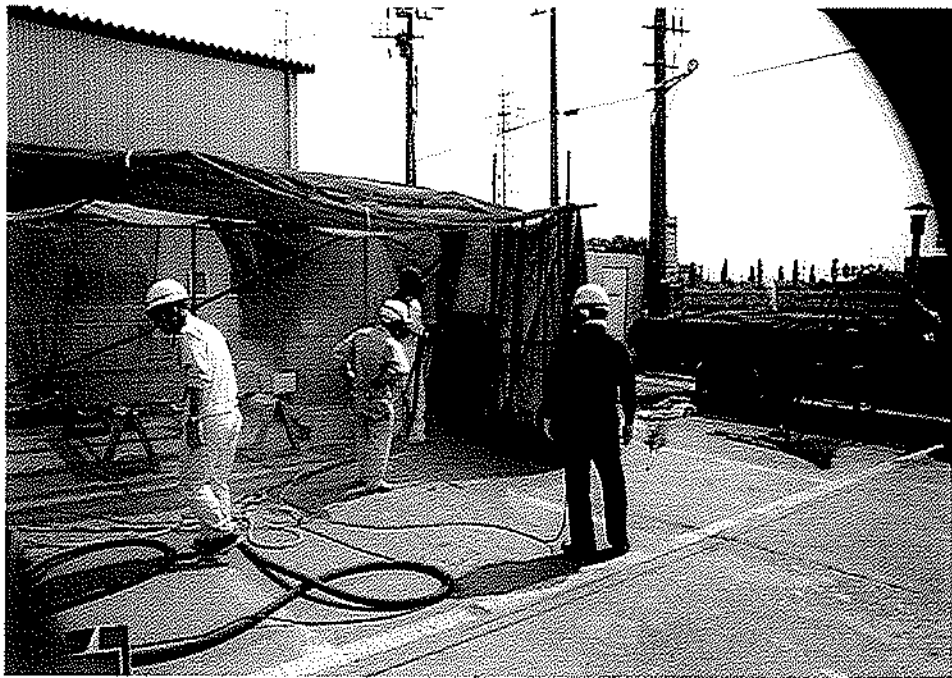
ガーネットによるドライブラスト ブラスト吐出圧力 : 0.6MP a ブラストノズル : 10mm φ
