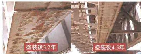
写真例：架設1919年、塗替え塗装後3～5年
