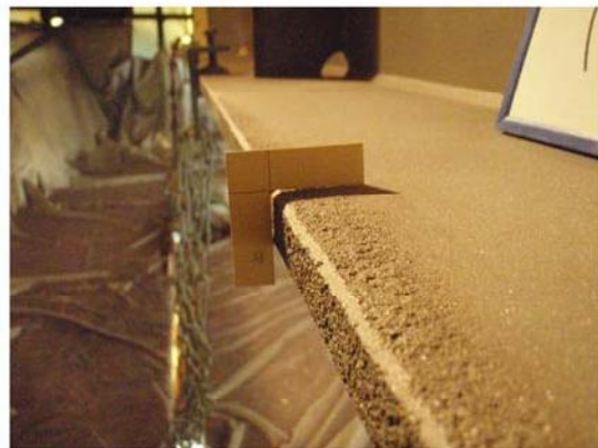
写真-10 塗替え塗装時の部材角部の処理
