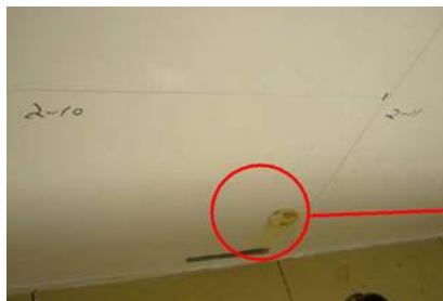
ブラスト工法処理前の状況
