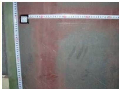
塗膜剥離材による処理後
