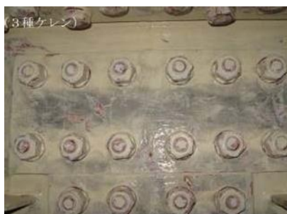
添接部 機械工具処理後
