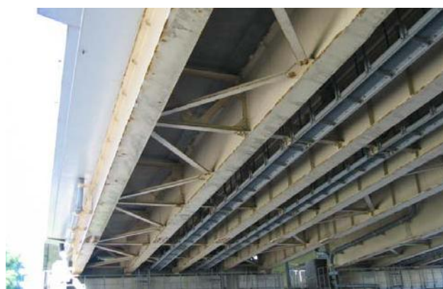
写真-2 塗替え塗装 (a-1 塗装系) の塗膜 (一般環境・道路交差点、約 6 年経過)
