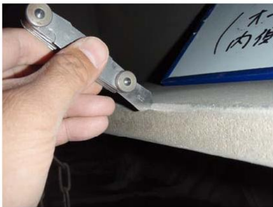
写真-10 塗替え塗装時の部材角部の処理
