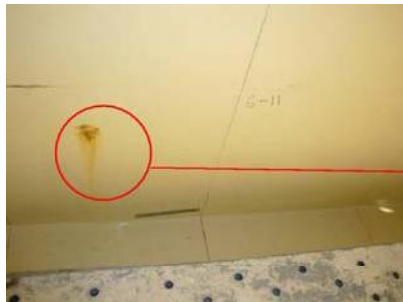
塗膜剥離材処理前の状況
