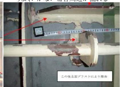
ノズルホースが入らない箇所 ブラスト処理ができない
