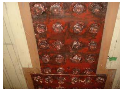
添接部 塗膜剥離材処理後
