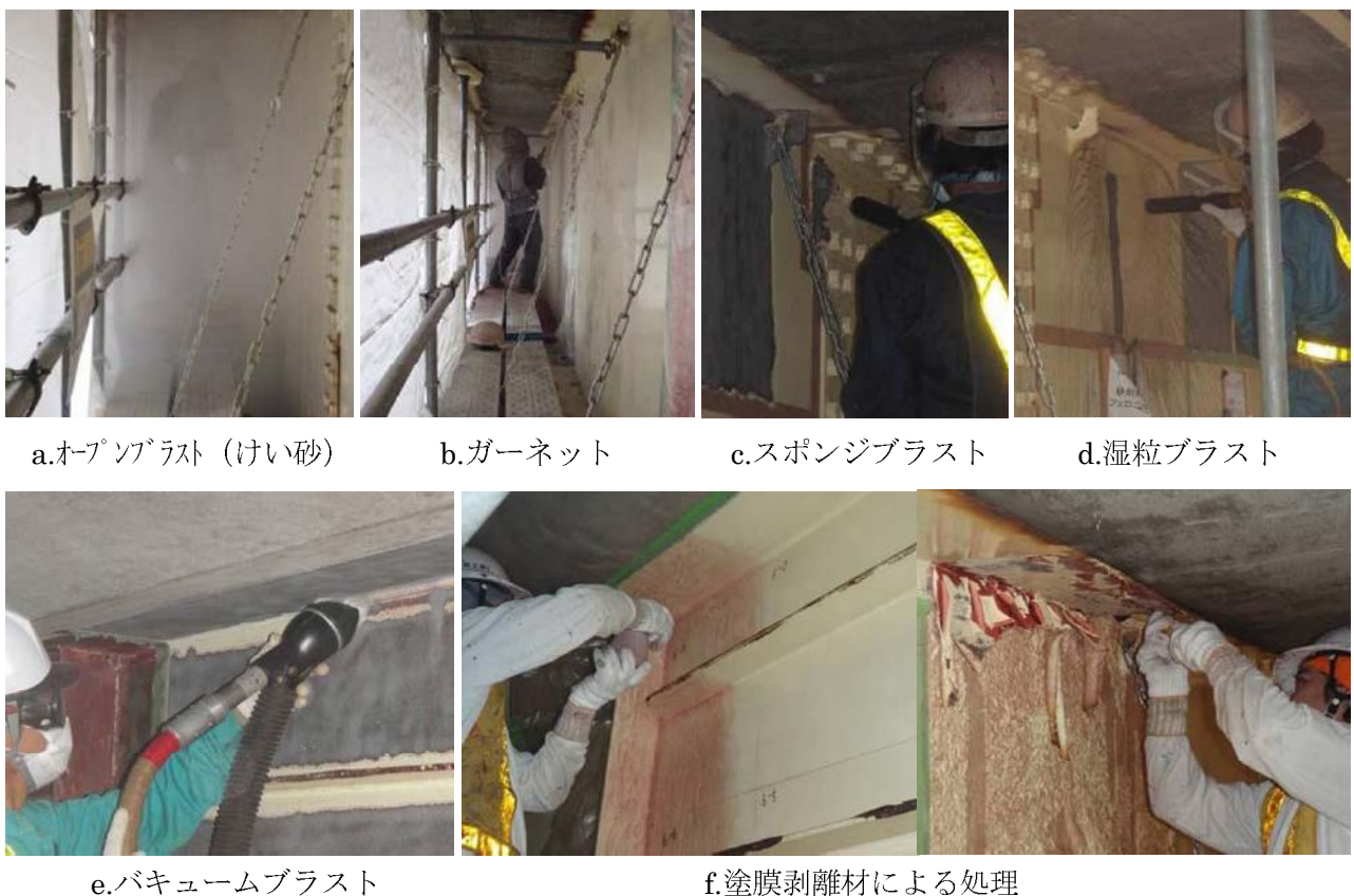
写真-8 各種塗膜除去工法の施工状況
