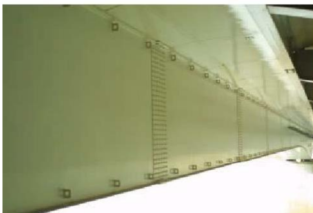
写真-3 重防食塗装 (C3 塗装系) の塗膜 (一般環境、約 15 年経過)
