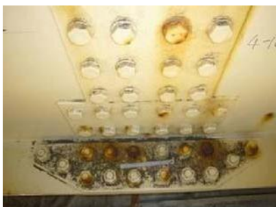
添接部 塗膜剥離材処理前
