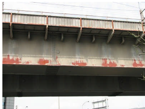
写真 3 上塗り塗膜の消耗（30 年後の外観） 都市環境，1977 年塗装，エポキシ樹脂塗膜
