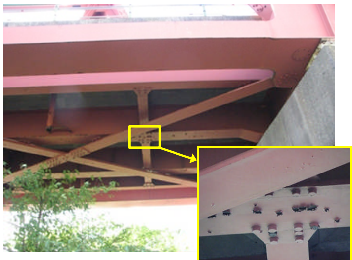
写真6 塗装系J-2の31年後 1976年塗装, 太平洋からの離岸距離約500m, 河川上
