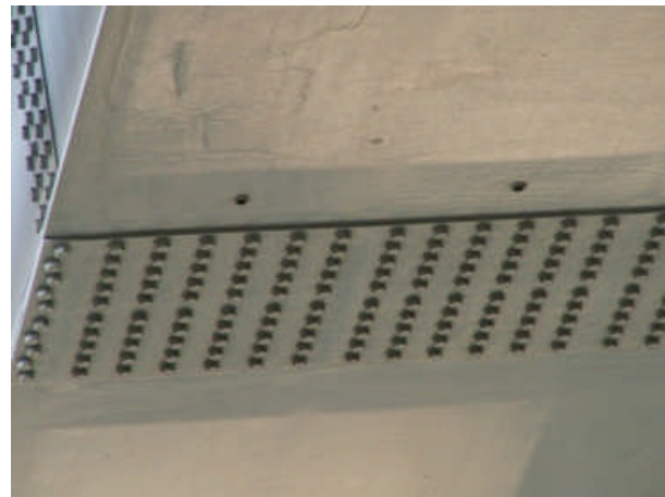
写真 2 全工場塗装と現場塗装の塗膜外観変化 都市環境，1984 年塗装，ポリウレタン樹脂塗膜
