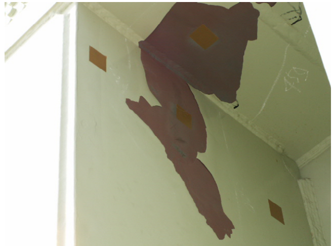
写真5 無機ジンクリッチ塗膜凝集破壊による大面積塗膜はがれ (1991年塗装)
