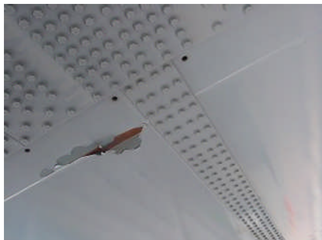
写真 4 全工場塗装の溶接線に沿ったはがれ都市環境、1983 年塗装、ポリウレタン樹脂塗膜
