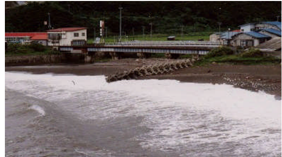
写真8 塗装系13A, 14Aの試験施工箇所 1976年全工場塗装, 日本海から約50m
