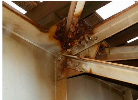
写真9 ガセット部の30年後
