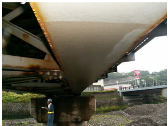
写真10 部材下面の30年後
