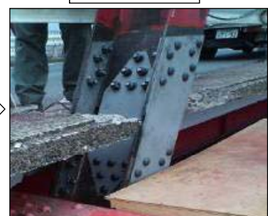
補修後の状況
