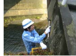
③自治体管理橋梁の点検状況
