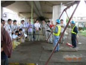
①現場での研修状況
