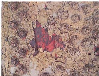
剥離剤を再塗付し、24時間放置後
