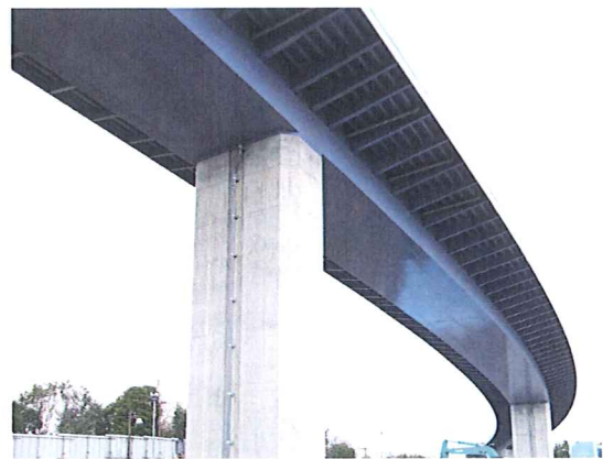
写真-5 改良型吊り金具を配置した全断面現場溶接桁
