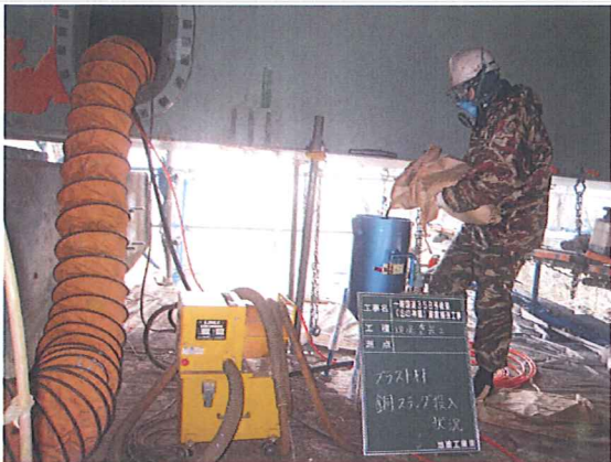
写真-3. 7 研削材（銅スラグ）投入状況
