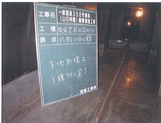
写真 3. 18 素地調整 1 種完了状況
