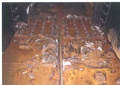
写真-3. 3 下り車線側桁内状況
