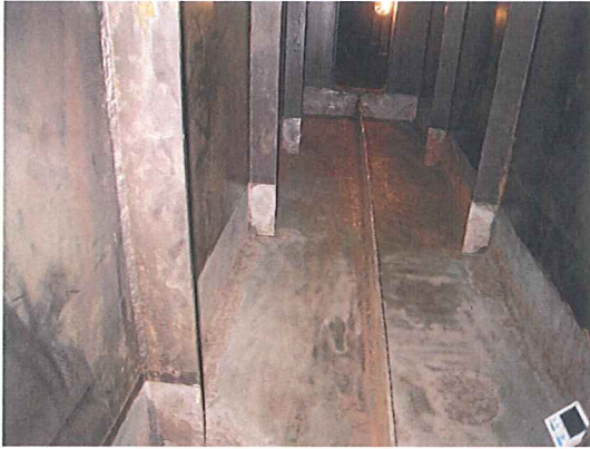
写真 3. 17 素地調整 1 種完了状況
