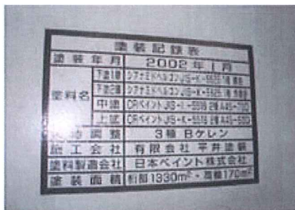
写真-3. 1 塗替塗装時の塗装歴
