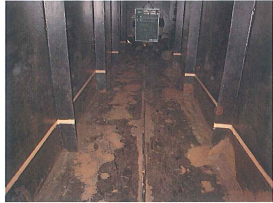
写真 3. 19 素地調整 3 種完了状況
