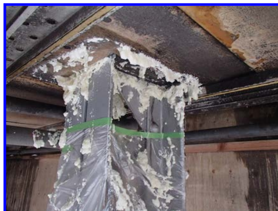
交差部下面(発砲材で止水を試みるが失敗) →
