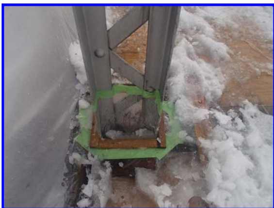
交差部下面(発砲材で止水を試みるが失敗) →
