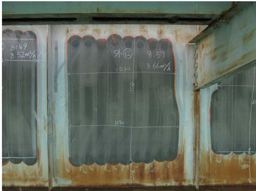
**図-3.8 自動走行式素地調整装置による素地調整結果の一例**
