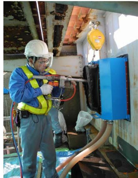
図-3.7 橋梁における素地調整作業の状況
