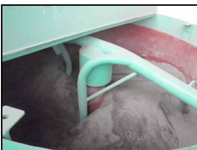
写真—4.9 攪拌中の様子
