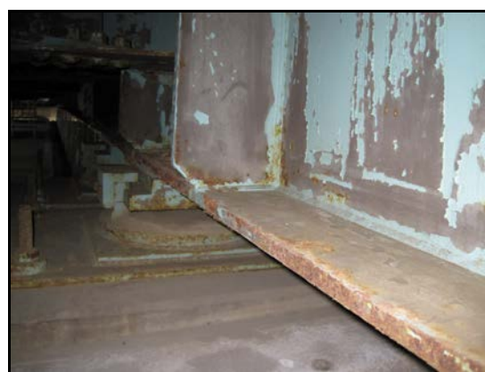
写真—4.2 ブラスト前の桁の塗膜状況 ウェブおよび下フランジ上面
