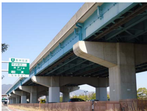
写真—4.1 橋梁の外観 写真は塗替え塗装後の状態
