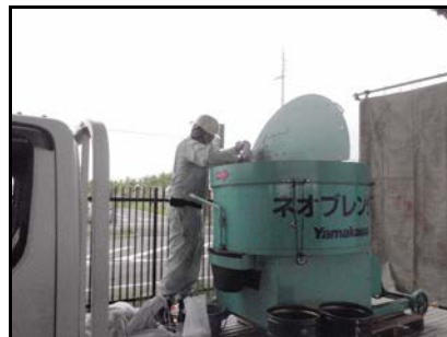
写真—4.6 廃材投入中
