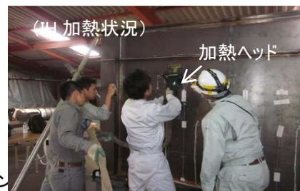
写真-5 計測および加熱状況
