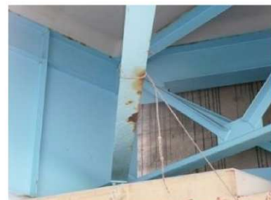
写真-4 SM 橋 施工後 1 年 4 ヶ月
