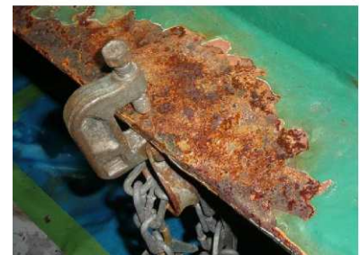
写真-9 足場クランプ部
