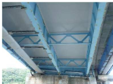
写真-3 SO 橋 施工後 1 年 2 ヶ月
