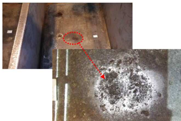
写真-14 2種ケレンの仕上がり状態 (2回目)
