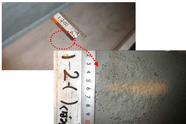
写真-13 1種ケレンの仕上がり状態 (1回目)
