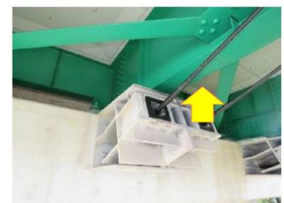
写真-11 モニタリングポイント外観 (施工後 8 ヶ月)
