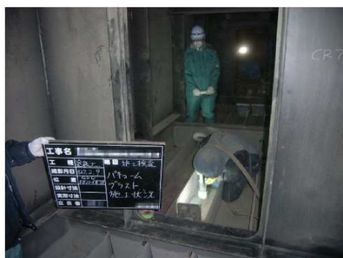
写真-15 ブラスト施工状況
