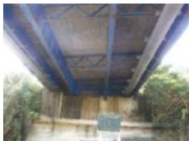
写真-2 SO 橋 施工前
