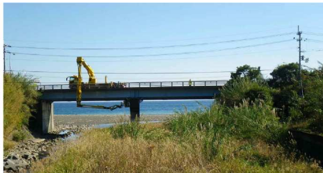
写真-1 SO 橋 架橋環境
