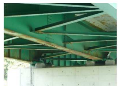
写真-8 塗替え後 3 年経過時点
