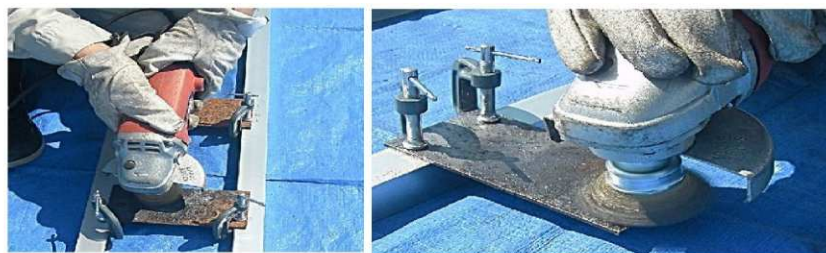
写真-4 素地調整 3 種の施工状況
