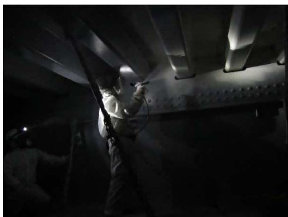
図—10 エアレス作業状況
