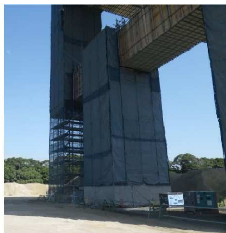
図—6 塗装機の設置場所
