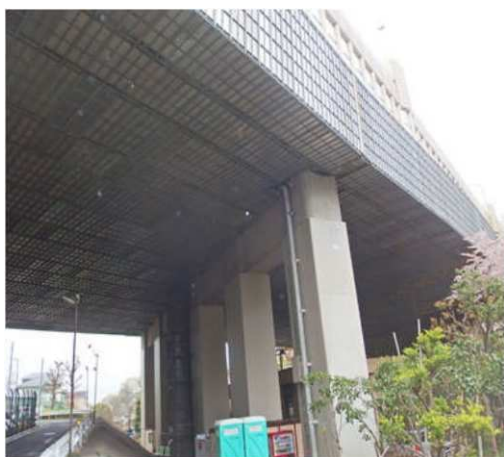
図—3 現場の外観
