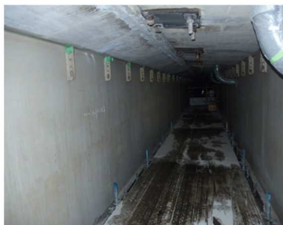
図—4 現場の内部
