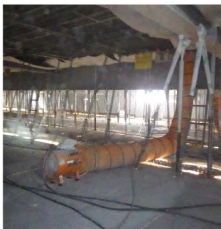
図—8 送付機による換気状況
