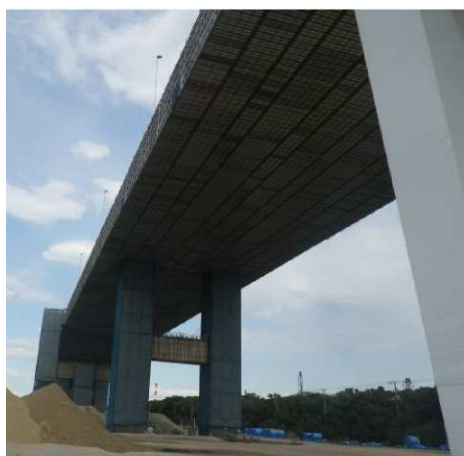
図—5 現場の外観
