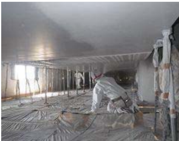
写真-3 水性塗料のスプレー塗装状況
