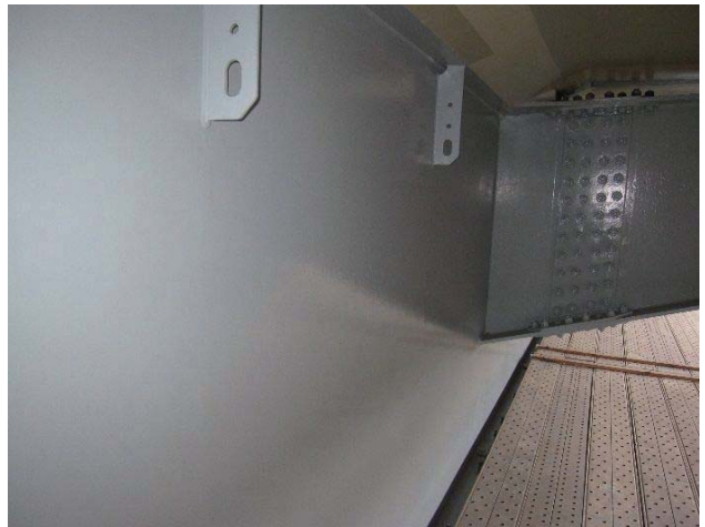
写真-4 仕上がり状況 (スプレー塗装)
