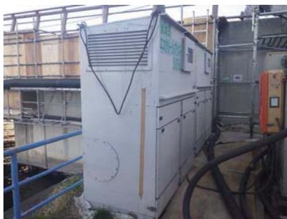
写真-11 換気・集塵装置設置状況
