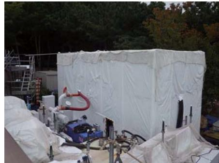
写真-14 防護シート養生状況
