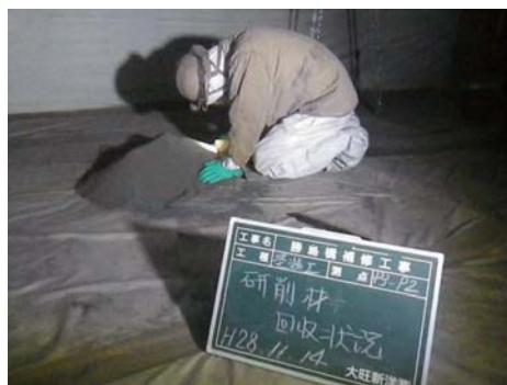
写真-33 研掃材回収状況
