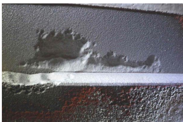
(1) 著しい局部腐食のブラスト後の事例
