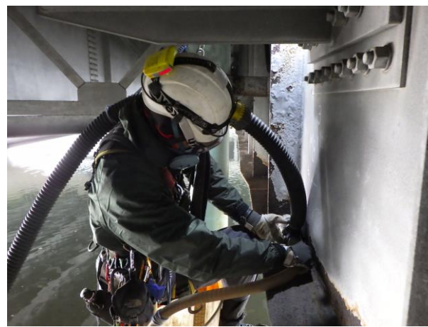
写真 16 バキュームブラストを用いた施工例
