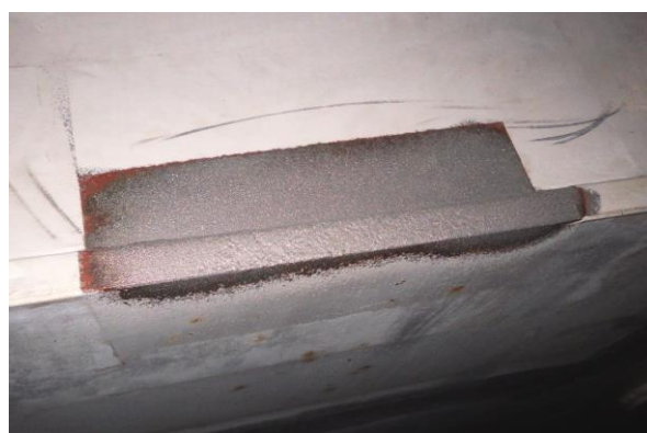
(2) 箱断面の下フランジ端部での施工事例
