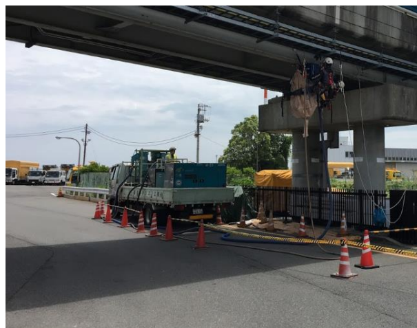
写真 15 資機材の配置例
