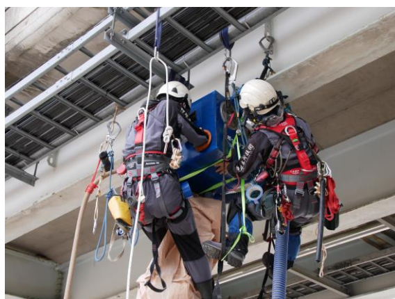
写真 10 段ボールを用いた特殊高所技術による施工
