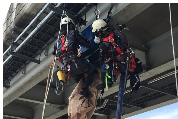
(2) 鉸桁の下フランジ下面の施工状況
