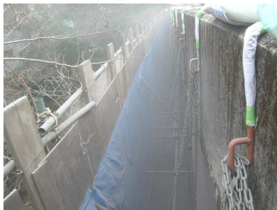
写真 8 足場からの粉塵飛散
