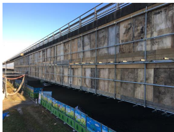
写真 9 足場全面板張り養生
