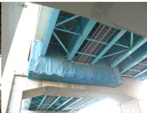
写真2 桁端部のみの足場
