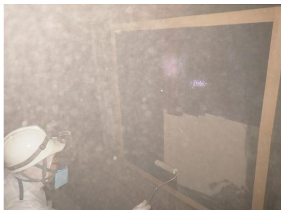
写真 4 Moistop K の塗付
