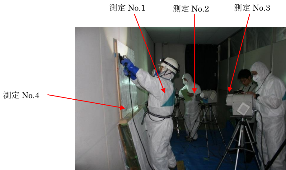
写真 1 素地調整作業
