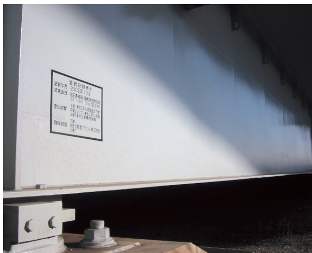
写真-1 施工15ヶ月後の状況
