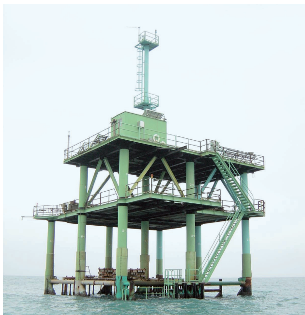
写真-1 海洋技術総合研究施設
