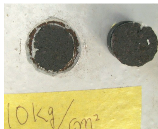
写真-11 さび層内からのはく離の例
