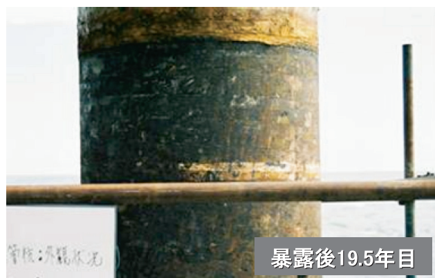
写真-8 (2) 鋼材の外観状況 (ペトロラタム系防食材を除去した状態)
