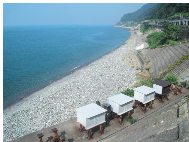
写真-7 橋梁模擬試験体の設置状況
