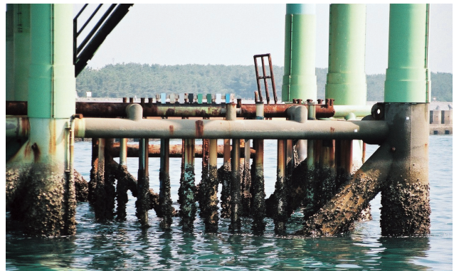
写真-2 干満部の鋼材防食試験体の暴露試験状況
