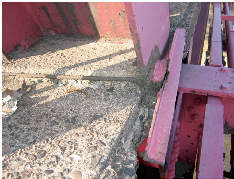
写真3 斜材の側面で錆の上から塗られた塗装
