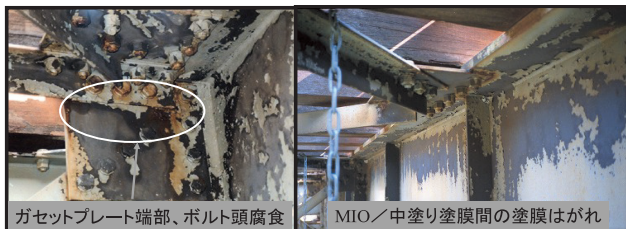
図-7 塗替え塗装施工試験前の塗膜変状 行合川橋りょう1990年頃
