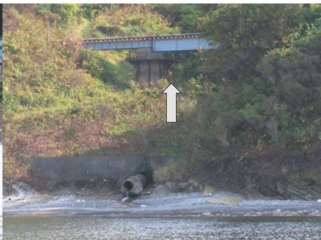
行合川橋りょう 離岸距離約100m, 桁高さ約20m
