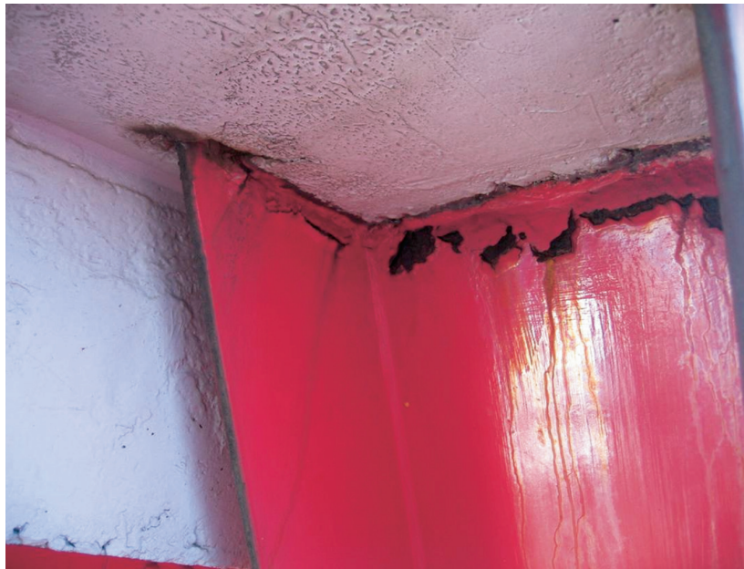
写真4 斜材の下側で錆層の上から塗られた塗装の例
