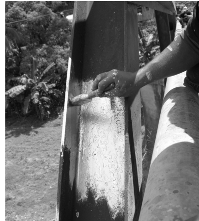
写真-10-2 再塗装作業
