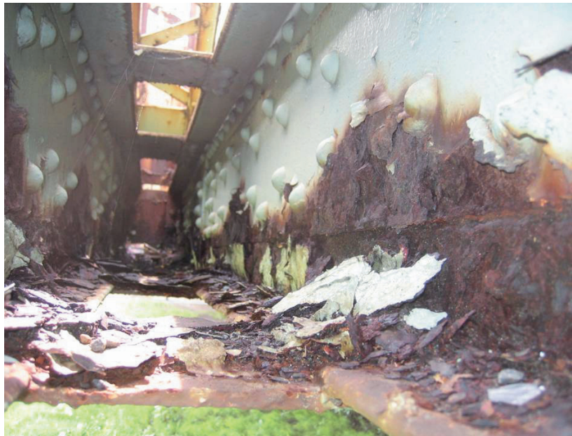
写真8 伊勢大橋の下弦材の腐食の状況
