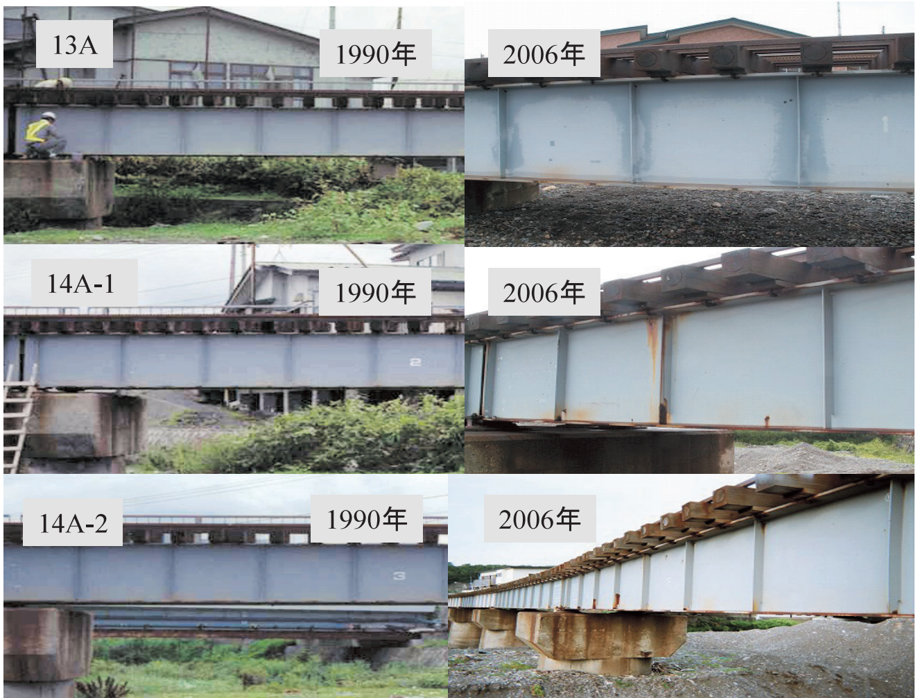
図-11 海側ウェブ外面の外観変化
