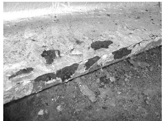
写真-9 適正な素地調整が行われないまま再塗装された塗膜
