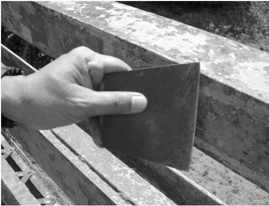
写真-10 鉄ヘラによる錆落とし作業
