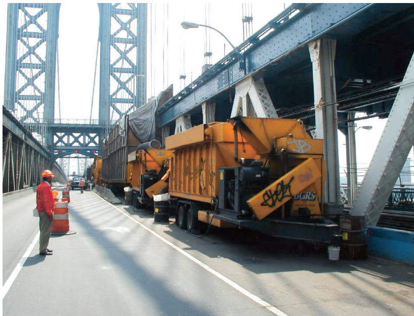
写真9 ニューヨークの吊橋補剛桁の塗替え塗装の状況
