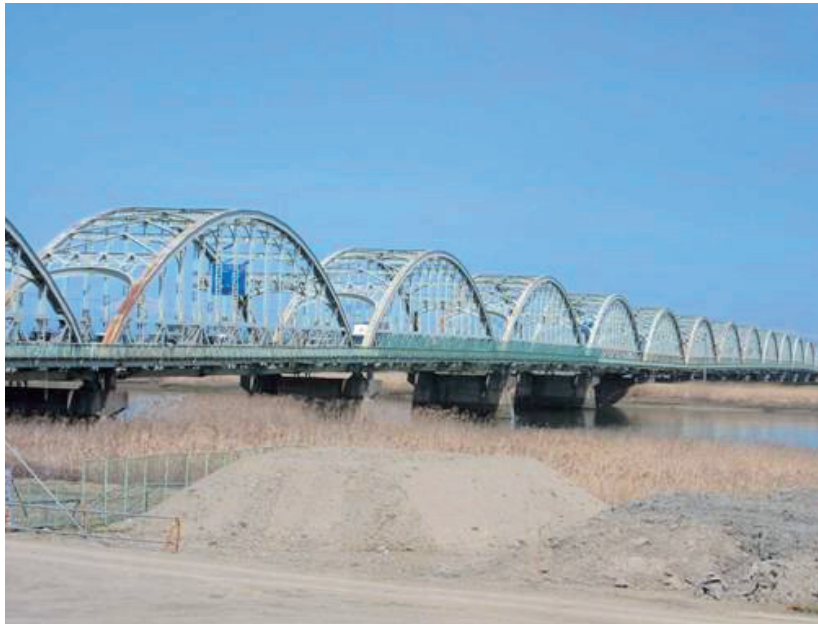
写真6 遠望でも塗膜の劣化がわかる伊勢大橋の現況
