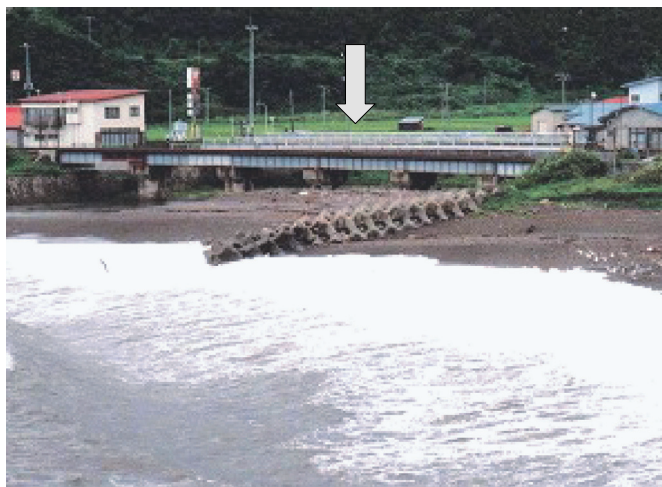
吾妻川橋りょう 離岸距離約50m, 桁高さ約5m
