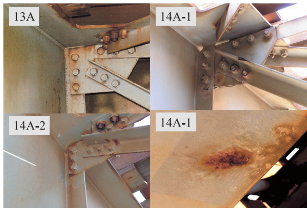
図-13 塗替え塗装塗膜の変状
