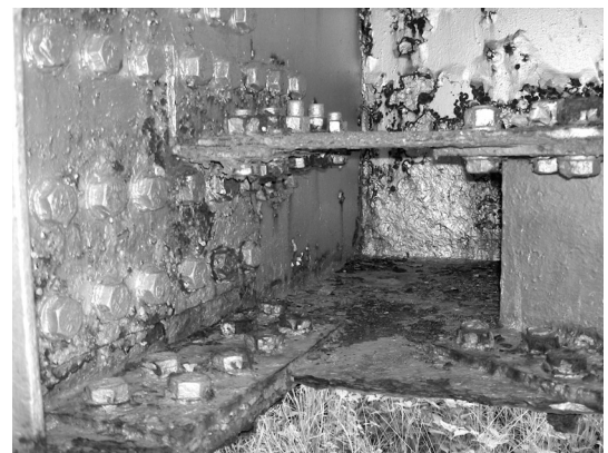
写真-8 錆による鋼桁端部の欠損事例(2)
