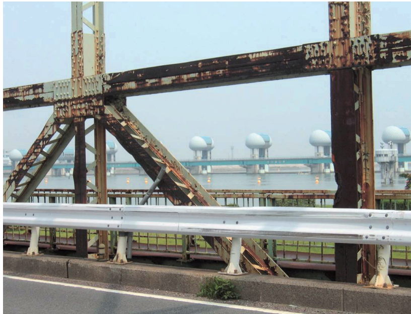
写真7 車両接触の跡もある伊勢大橋の腐食状況
