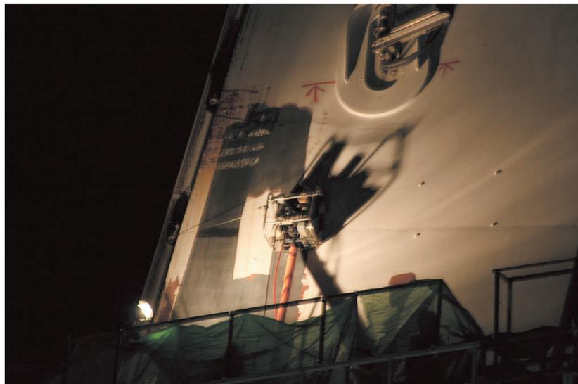
写真8-2 つばさ橋主塔での剥離工事
