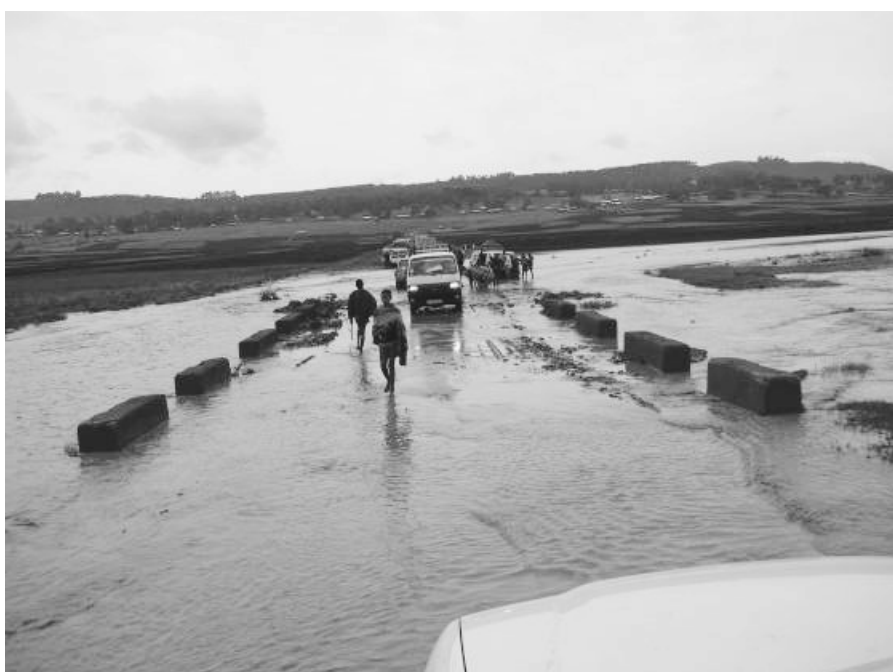
写真-11 雨季に通行できない橋
