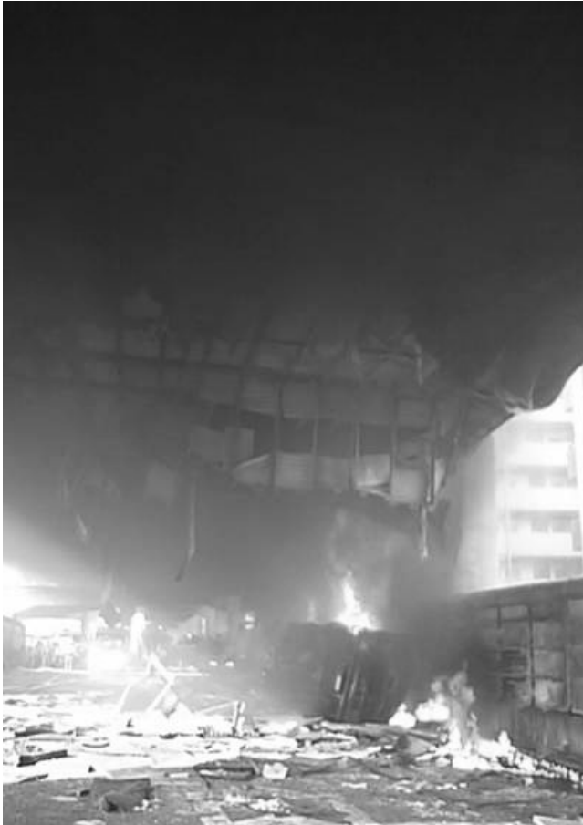
写真-1 火災状況
