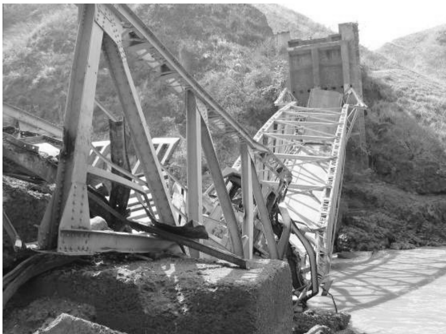
写真-10 通行中のトレーラーが衝突して落橋した鋼トラス橋
