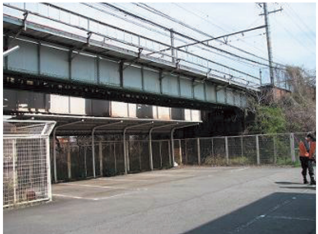
写真-2 試験施工箇所
