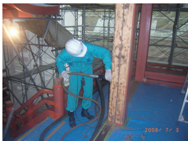
寒冷紗撤去作業中
