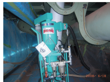
使用装置 FDO-G1KA（足場内に設置）
