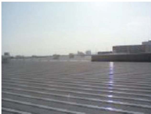
2008年10月測定「ゼッフル遮熱工法」で非空調時の倉庫内温度が13℃低下
