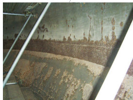
タンク下部腐食状況
