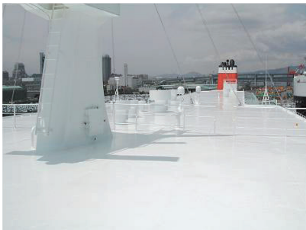
2008年8月測定「ゼッフル遮熱工法」で非空調時の客室温度が5℃低下
