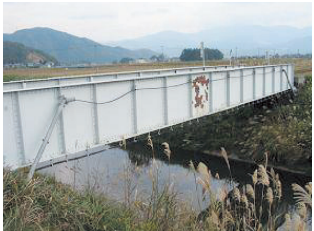
写真-1 大面積剥離の事例
