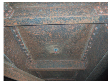
電動工具による1次処理施工中 1次処理完了（黒皮が残った状態）
