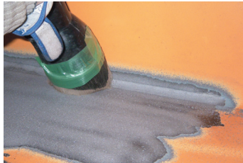
入隅部施工中
