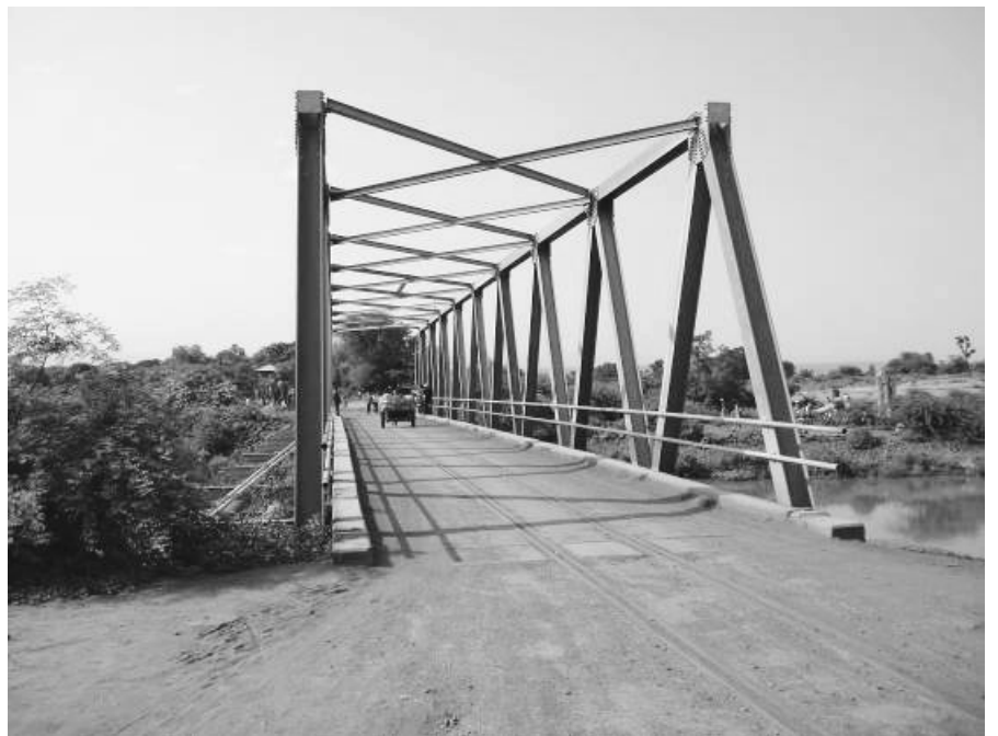
写真-7 亜鉛メッキした簡易構造の鋼トラス橋
