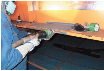
フランジ部施工中
