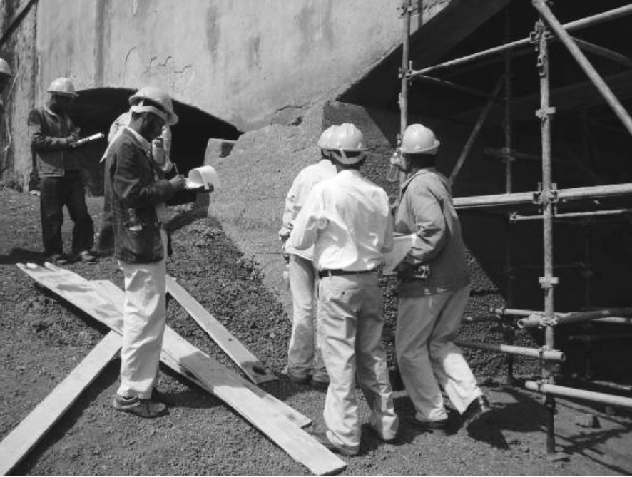
写真-12 橋梁点検の実習
