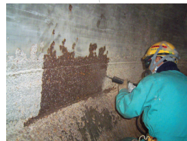
電動工具による一次処理
