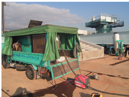
小型プラスト機での施工
