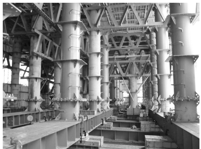
写真-3 仮受けベントの設置
