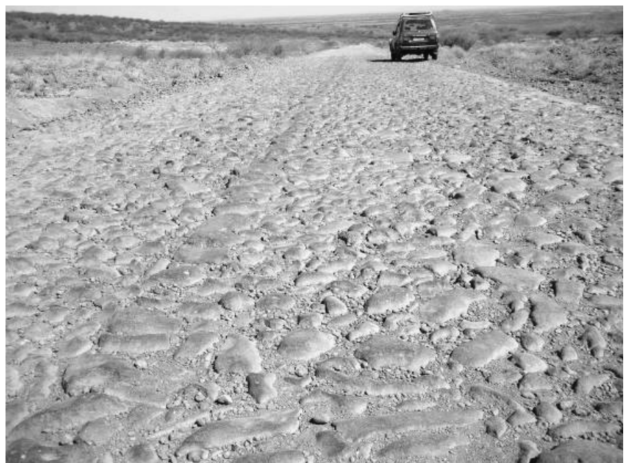
写真-5 占領時代に建設した道路
