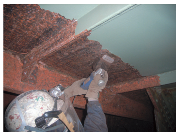
電動工具による1次処理施工中 1次処理完了（黒皮が残った状態）
