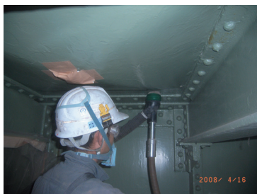
施工前（1次処理無）
