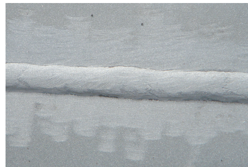
施工完了 ISO Sa2 1/2 レベル
