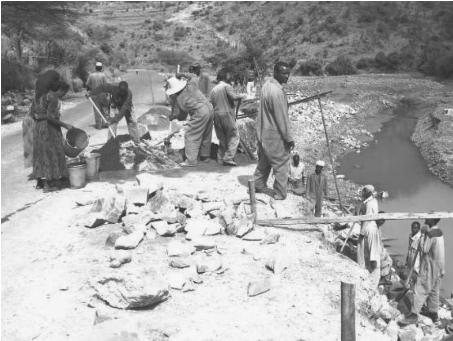
写真-8 石積み擁壁の補修をする作業者
