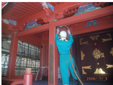
漆材撤去作業中
