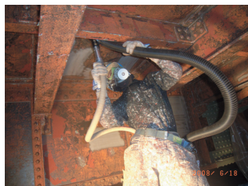
ブラスト施工中
