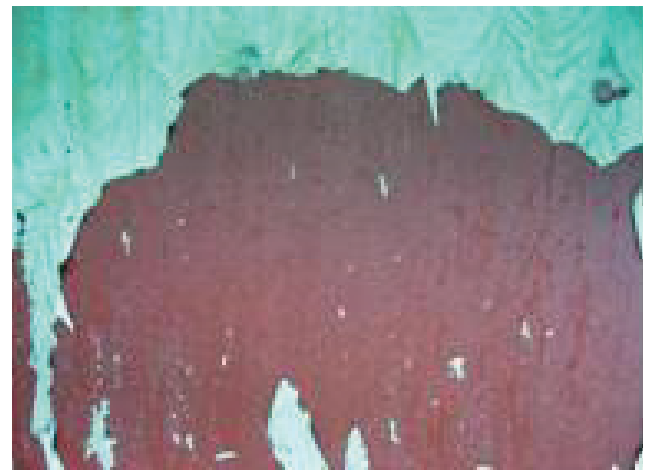
写真-3 1回目塗布後の剥離性状
