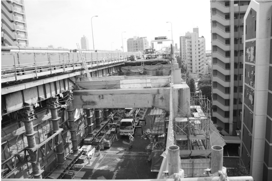
写真-4 上部工撤去（西側部分）
