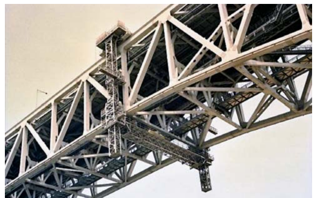
写真-2 桁外面作業車（曲弦トラス）
