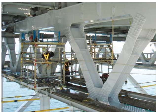
写真-11 小組トラスのスライド足場
