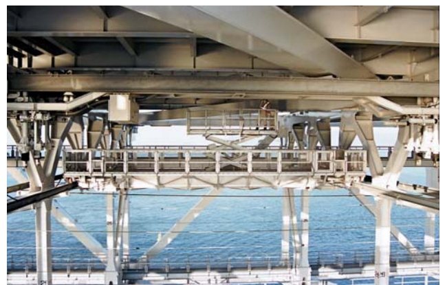
写真-3 桁内面作業車
