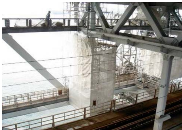
写真-9 主横トラスの枠組足場
