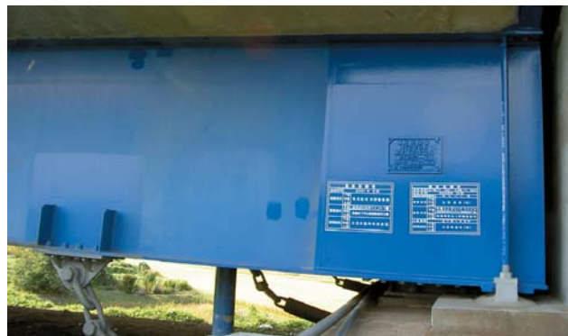
図-7 実橋における部分塗替え塗装の試験施工
