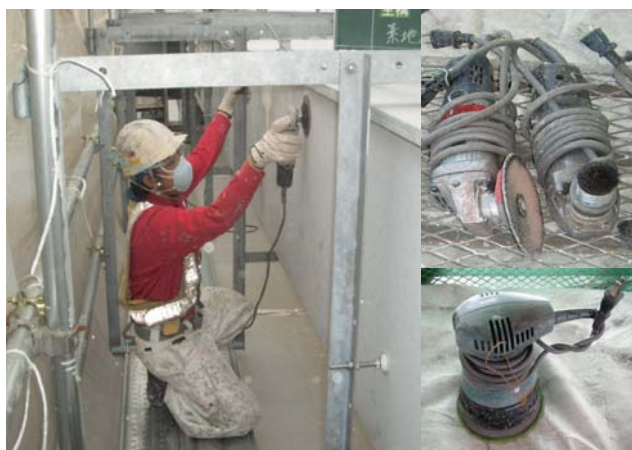
写真-7 素地調整作業及び電動工具
