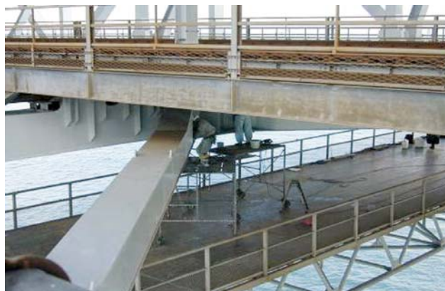
写真-12 外面作業車上の足場
