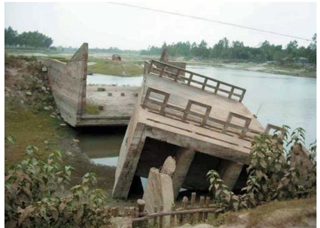
写真-7 洪水で破壊されたボックスカルバート
