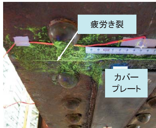
図-9 下フランジカバープレート溶接 (止端部からの疲労)
