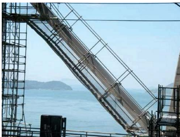
写真-10 主構トラス斜材のユニット足場
