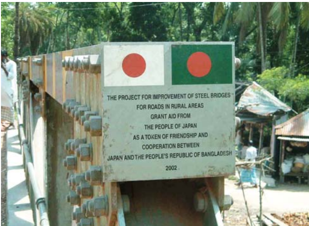
写真-6 日本の無償資金協力で架けた小型トラス橋（ Bangladeshの国旗は日の丸と色違い）
