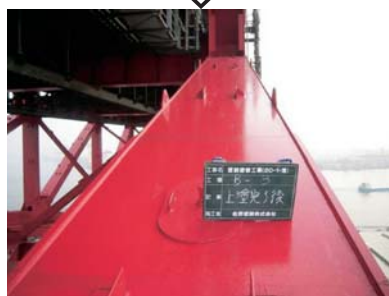
vii) 上塗り後（施工後）
