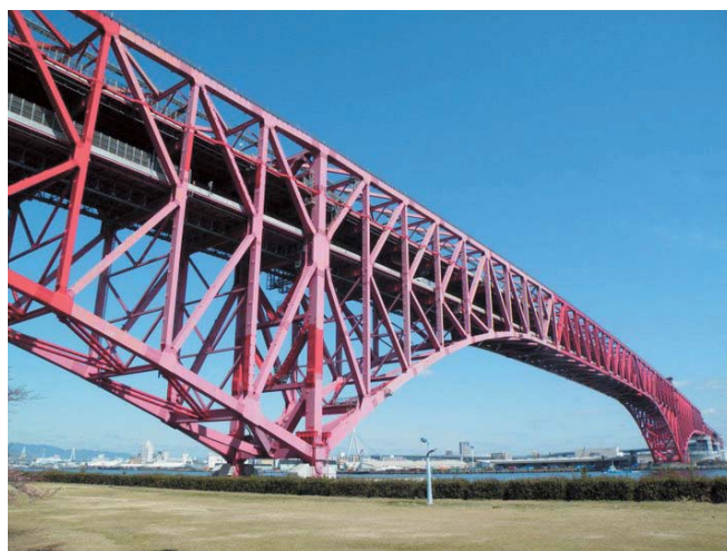
写真-1 港大橋の全景
