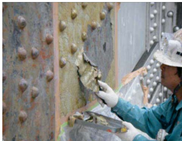
図-12 塗膜剥離作業の状況 31)
