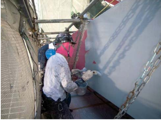
写真-6 ハケ塗り状況（一般部）
