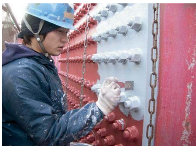
写真-10 ウェット塗膜厚測定状況
