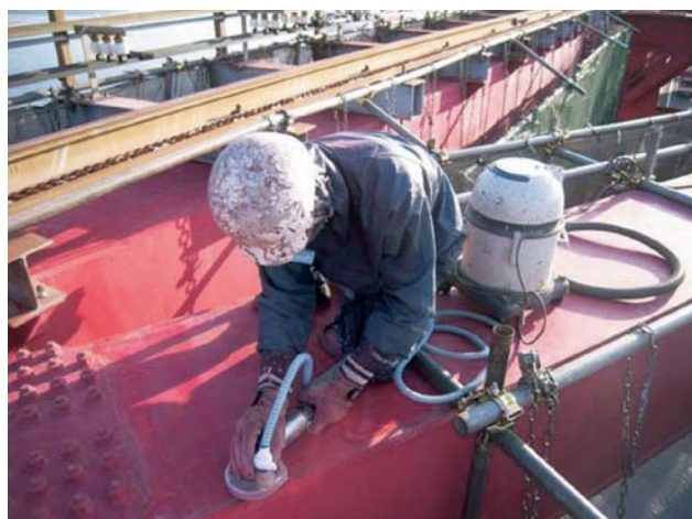
写真-9 バキューム式グラインダーによる素地調整
