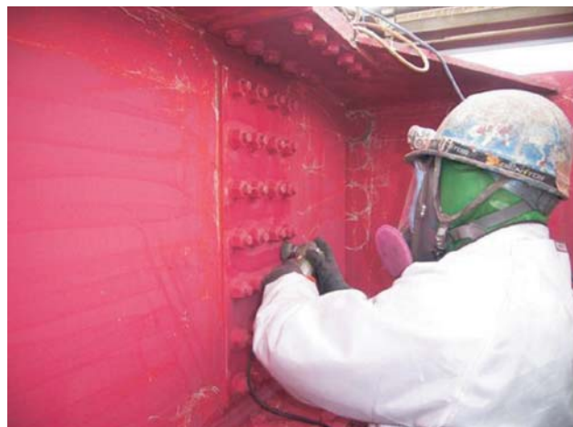
写真-5 カップワイヤーブラシによる素地調整
