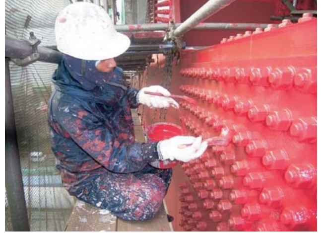
写真-7 ハケ塗り状況（ボルト添接部）
