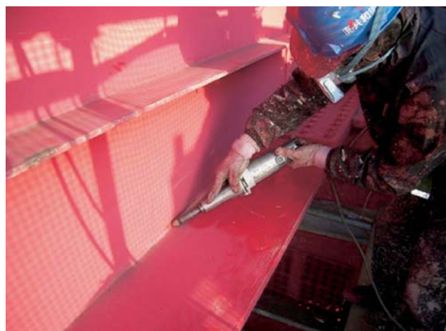
写真-8 棒グラインダーによる素地調整
