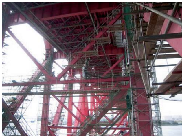
写真-3 吊材・対傾構足場設置状況
