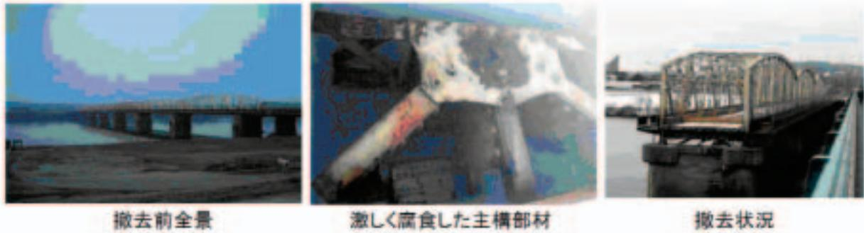
図-6 腐食老朽化により掛け替えられた橋梁
