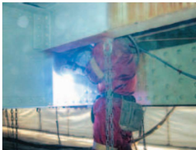
写真-6 金属溶射による塗替え
