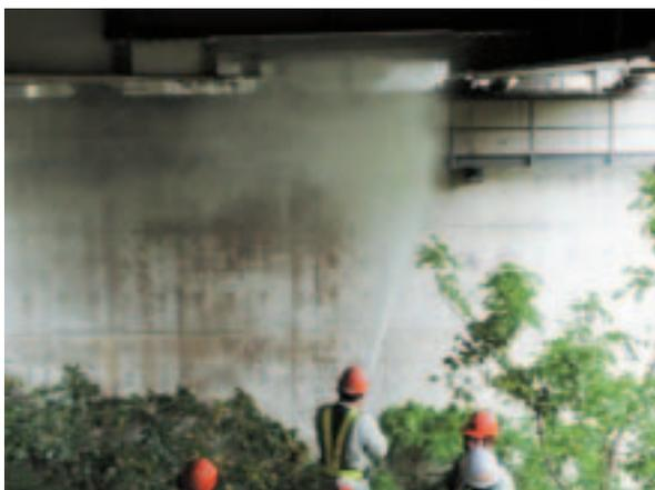
写真-5 洗浄（左：高圧洗浄、右：モップ洗浄）
