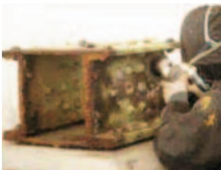
写真-2 電度工具処理の作業状況
