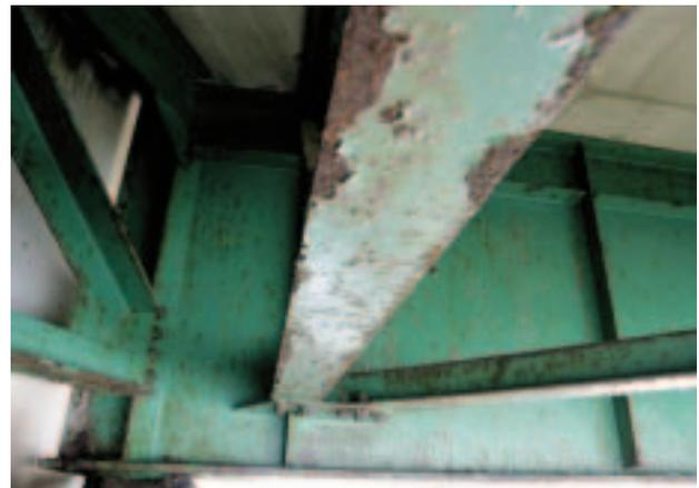
写真-7 鋼橋塗装の弱点部
