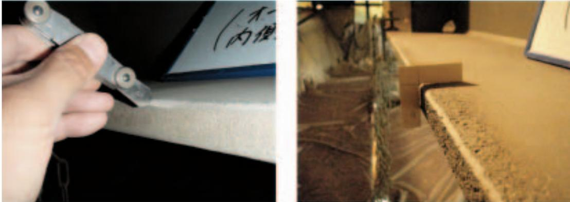
写真-7 塗替え塗装時の部材角部の処理
