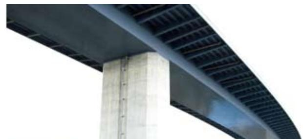
写-5 改良型吊り金具を配置した全断面現場溶接桁
