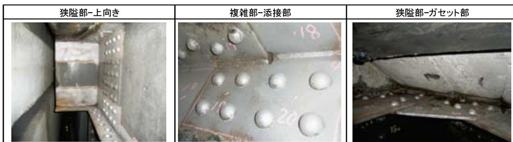
図-14 狭隘部のブラスト施工後状況
