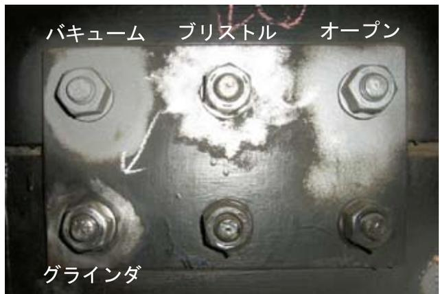
図-13 機材別の素地調整後外観比較
