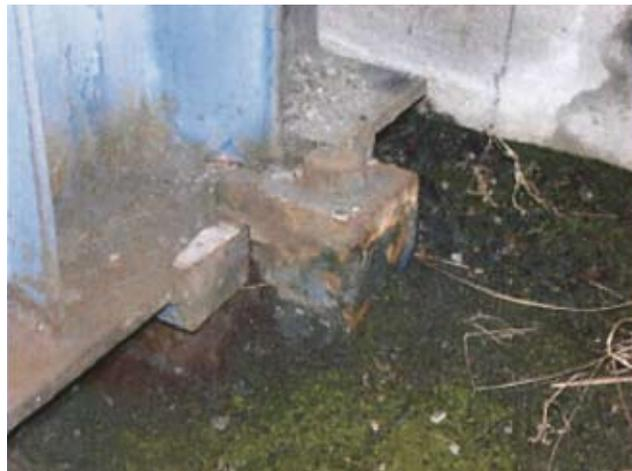
写真-2 鋼桁端部の著しい腐食
