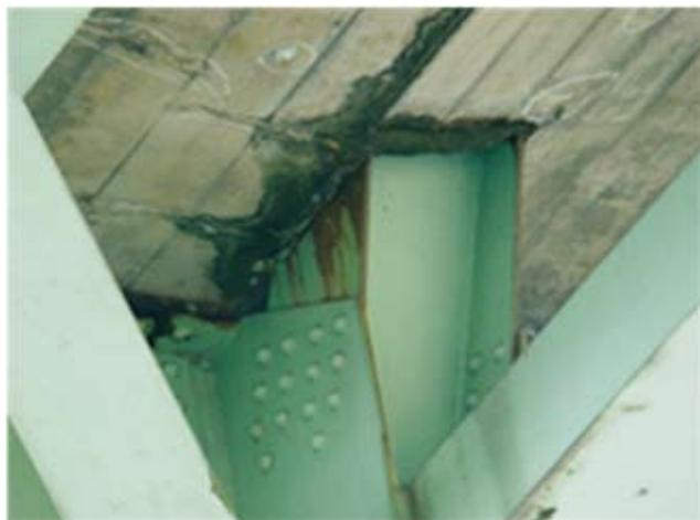
写真-1 鋼斜材が床版を貫通する部位の腐食
