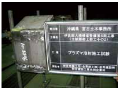
写真-7 施工試験前
