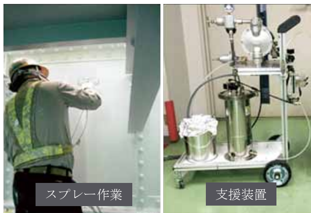
写真-6 主桁ウェブのスプレー塗装
