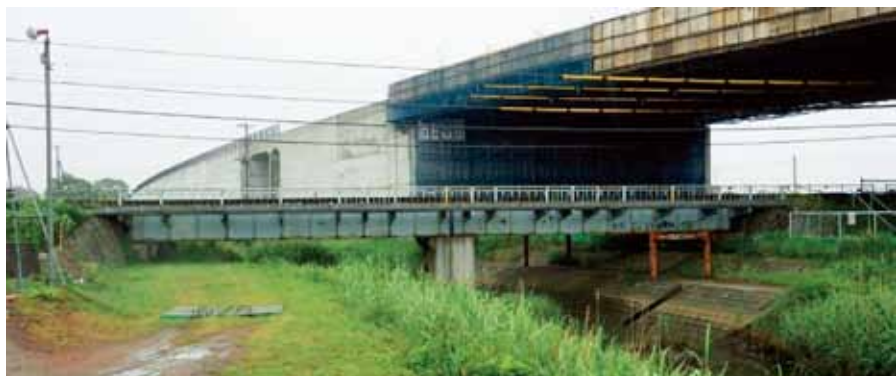
写真-4 試験対象橋梁
