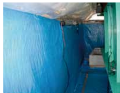
図-7 防護工内部の状況
