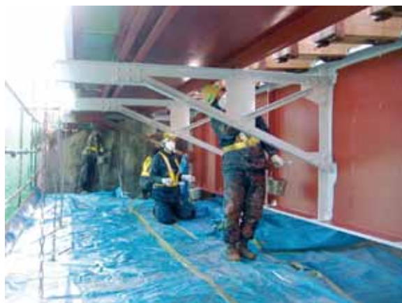
写真-1 鉄道橋りょうの塗替え状況
