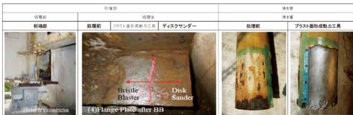
写真-11 桁端部、排水管での処理事例 10)
