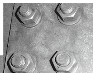
▲電動工具による素地調整後
