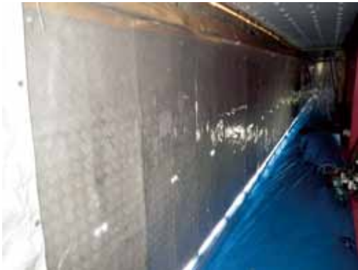
図-17 防護工内部の状況
