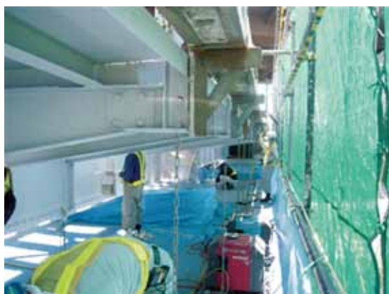
写真-8 足場床面および朝顔部のブルーシート養生
