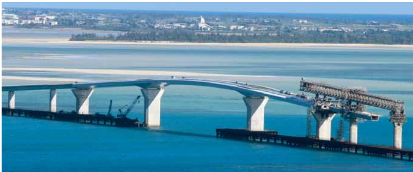
写真-1 完成状況
