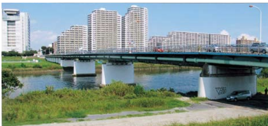
写真-1 ガス橋—多摩川—
