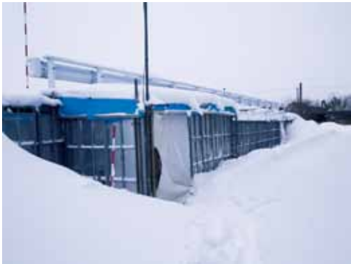
図-16 防護工全景
