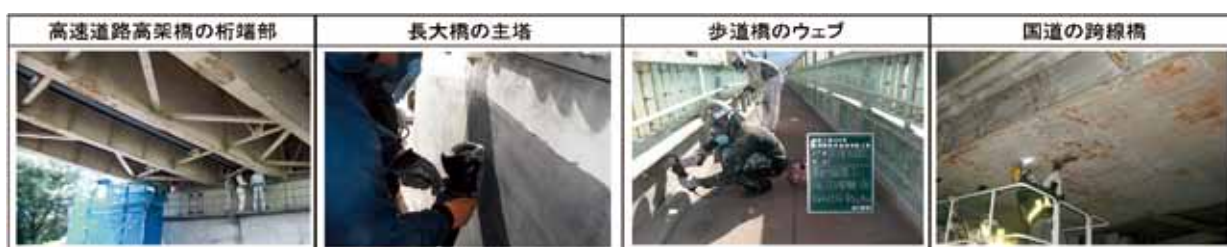
写真-8 ブラスト面形成動力工具の施工状況
