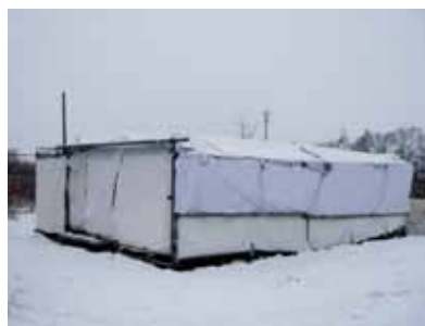
図-6 防護工全景
