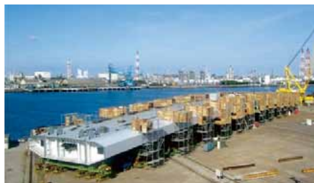
写真-2 工場地組み立て状況
