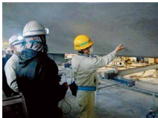
工程⑩：出来形確認状況
