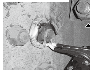
▲ボルト及びナット部施工(加熱中)
