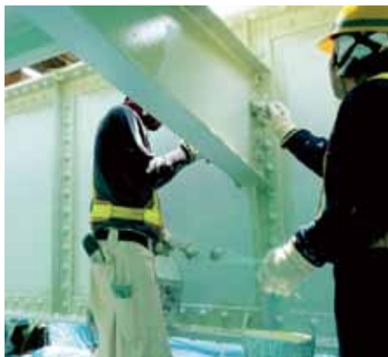
写真-5 先行はけ塗り状況
