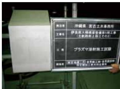
写真-8 プラスト完了
