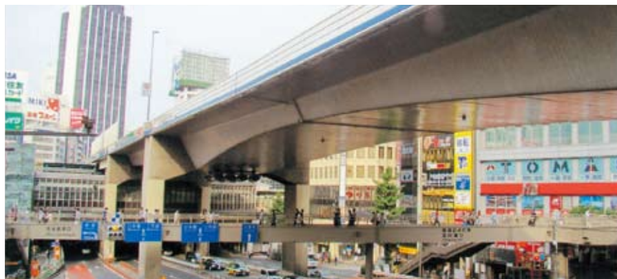
写真-2 渋谷高架橋—首都高速道路—
