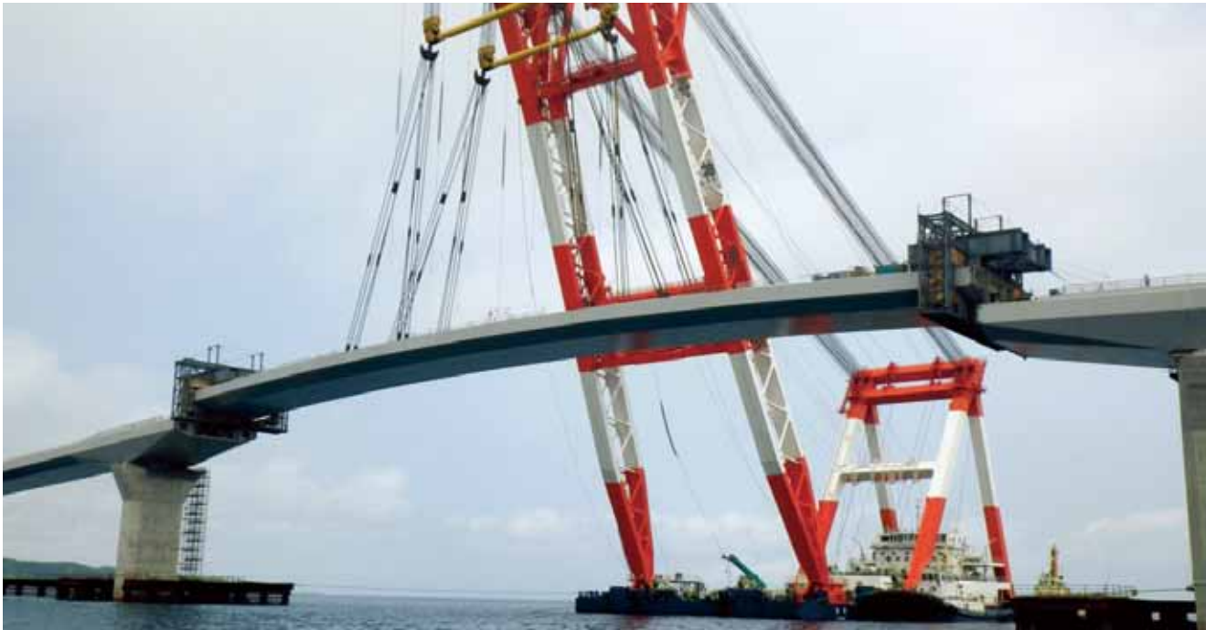
写真-4 中央径間の一括架設状況
