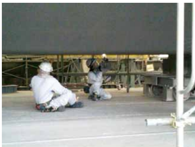
工程④：一次ブラスト品質確認状況
