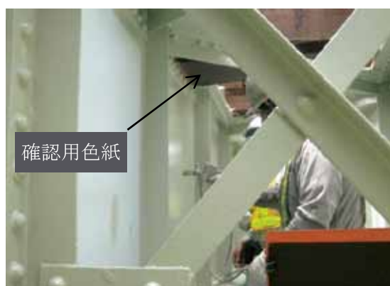
写真-11 ウェブ上方への塗料飛散確認
