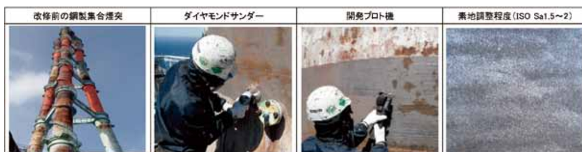
写真-13 開発プロト機の施工状況
