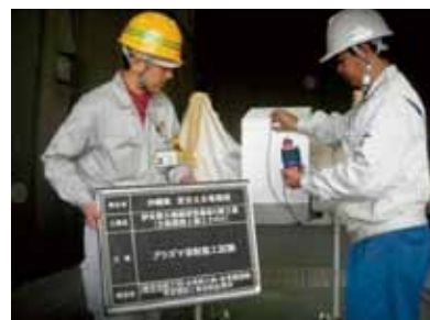
写真-12 溶射中の膜厚管理
