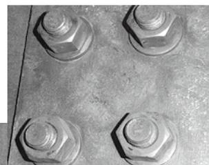
▲電動工具による素地調整後
