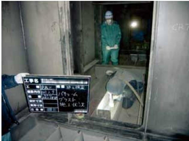
写真-15 ブラスト施工状況
