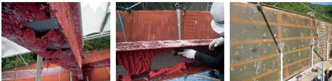
写真-5 塗膜剥離剤による剥離状況 (左：膨潤軟化状態、中：スクレーパー除去：右：除去後の状態)
