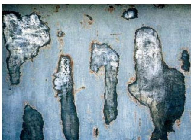
動力工具を用いて替ケレン-2を適用した状態であり、鋼素地露出箇所にさびは残存していない
