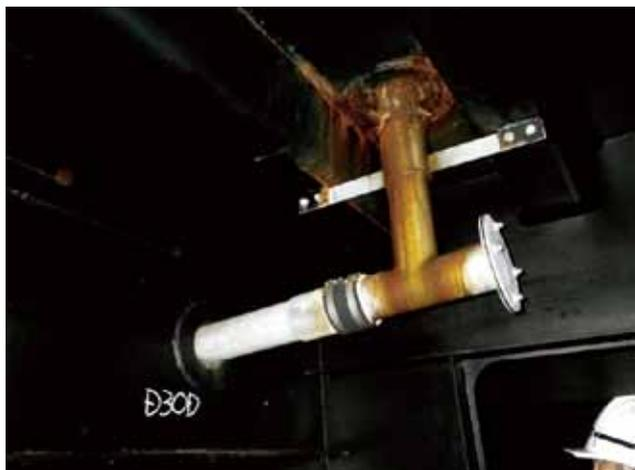
写真-11 箱桁内部の排水柵から漏水
