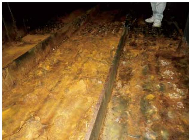
写真-12 箱桁内部の腐食
