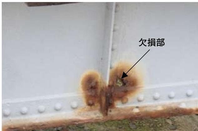
図-8 局所的な腐食により部材の欠損に至った事例
