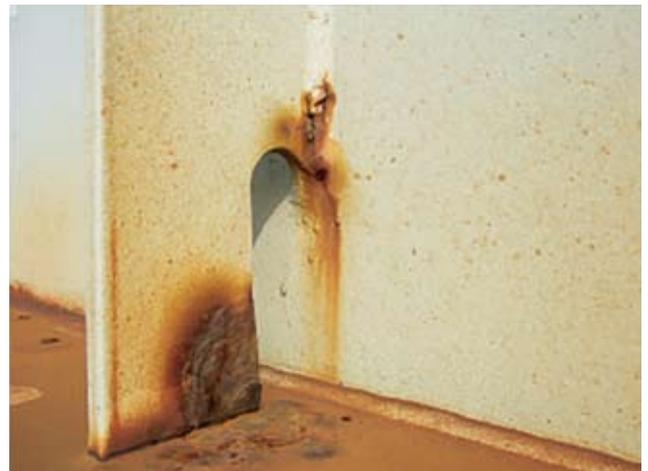
図-2 局所的な塗膜変状および腐食を生じた部材の例
