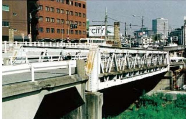
図-1 最古の鋼鉄道橋（現・浜中津橋）<sup>2)</sup>
