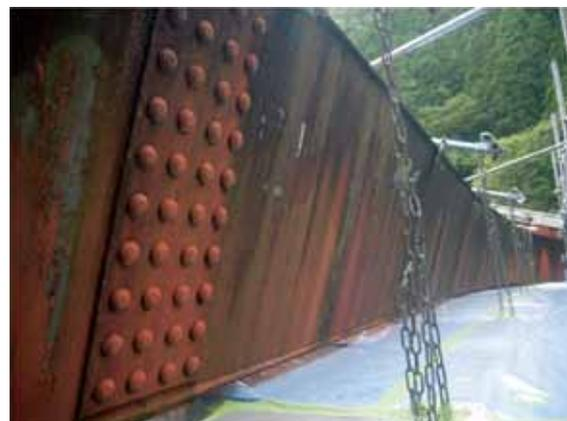
写真-2 塗替え前の腐食劣化状況
