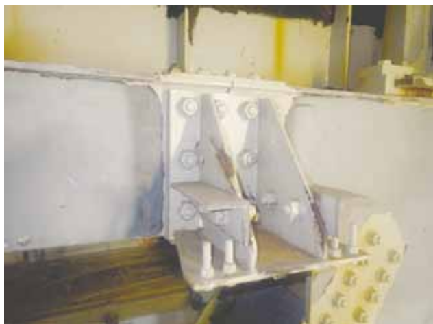
写真-6 IH工法の剥離困難箇所（ボルト継手部）
