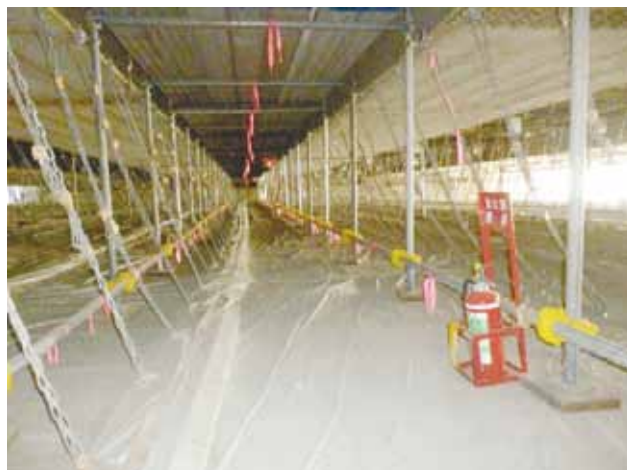
写真-2 足場内（都市高速）橋塗協提供
