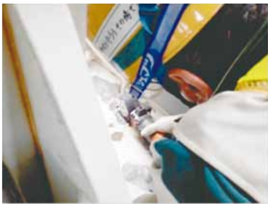
写真-5 ブラスト面形成動力工具施工状況
