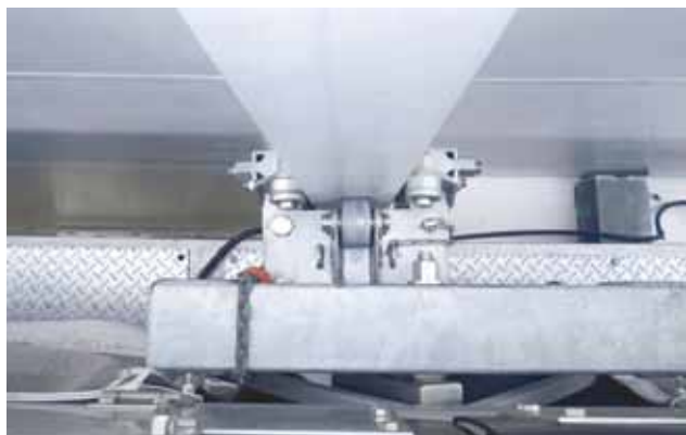
写真-6 ガイドレール支持状況
