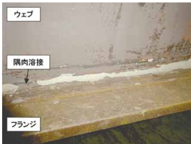
写真-7 IH工法の剥離困難箇所（すみ肉溶接部）
