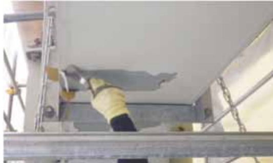
(3) 塗膜の剥ぎ取り
