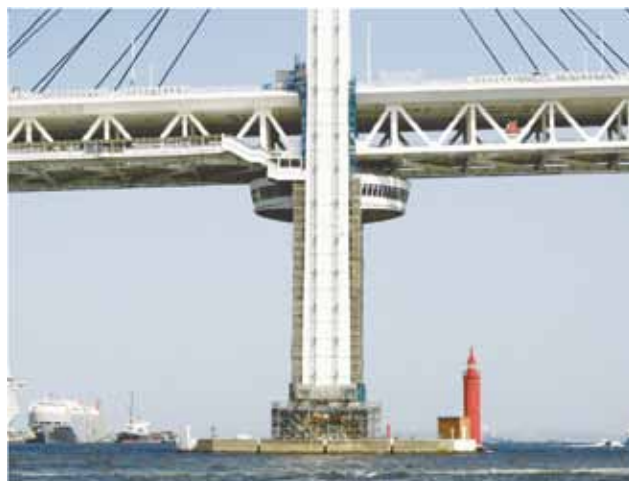
写真-7 移動昇降式足場（着床架台設置時）
