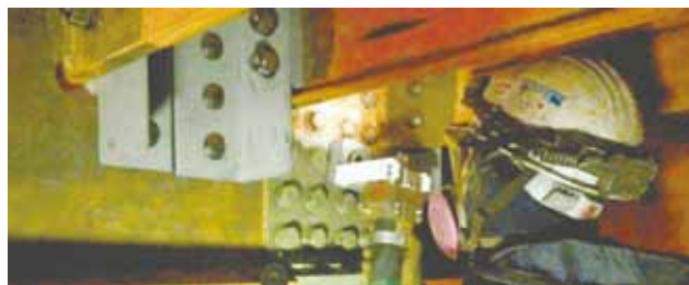
写真-13 特殊コイルによるボルト部の施工例
