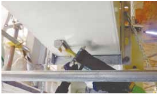
(1) 加熱ヘッドによる加熱
