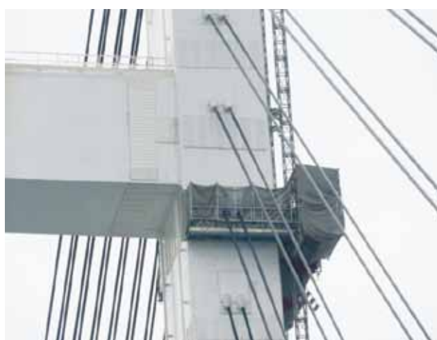
写真-8 移動昇降式足場（ケーブル面塗装時）
