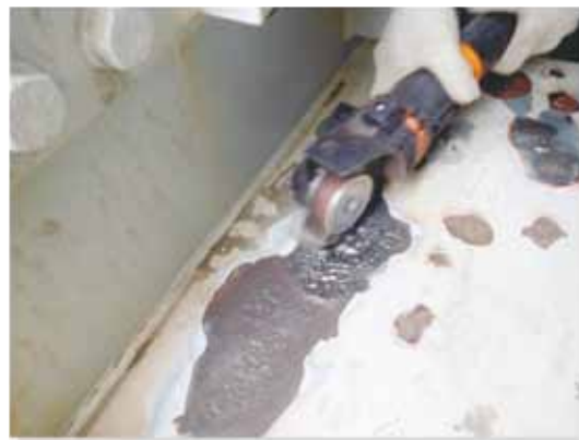
写真-5 ブラスト面形成動力工具施工状況
