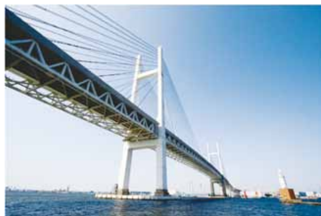
写真-1 横浜ベイブリッジ全景
