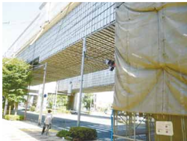
写真-1 鋼橋塗替え工事（都市高速） 橋塗協提供
