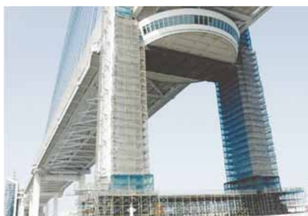
写真-9 枠組足場（主塔基部用）
