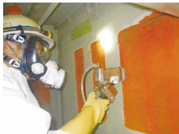
写真-11 開発機による施工状況
