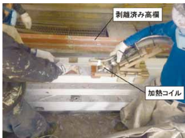
写真-10 フィールドテスト状況 (試作機による関門橋の鋼製高欄の塗装剥離)
