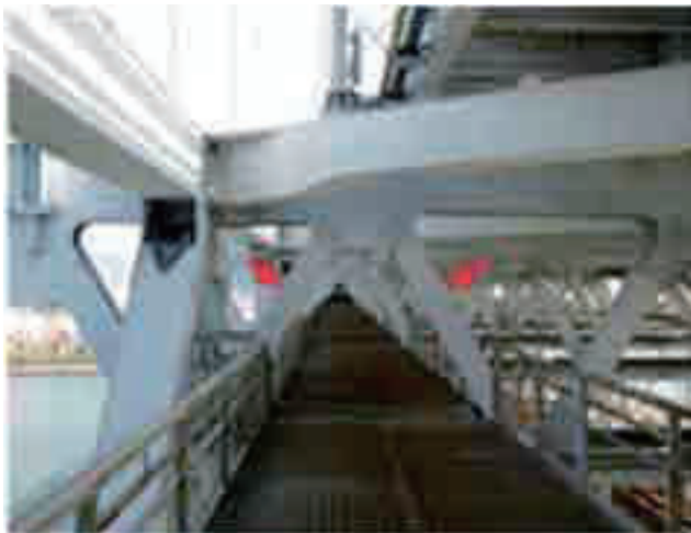
写真-1 H24 試験施工
