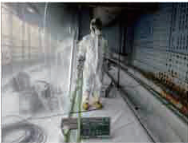
写真-5 作業者と防護養生の状況
