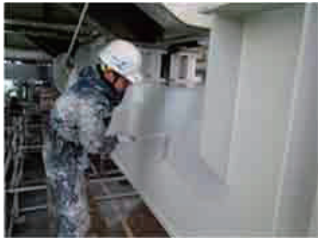
写真-2 H25 試験施工 塗装作業
