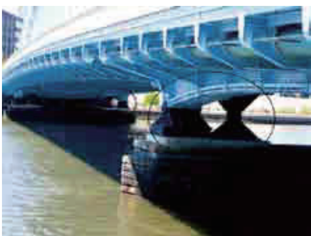
写真-5 ペトララムで再被覆した支承部
