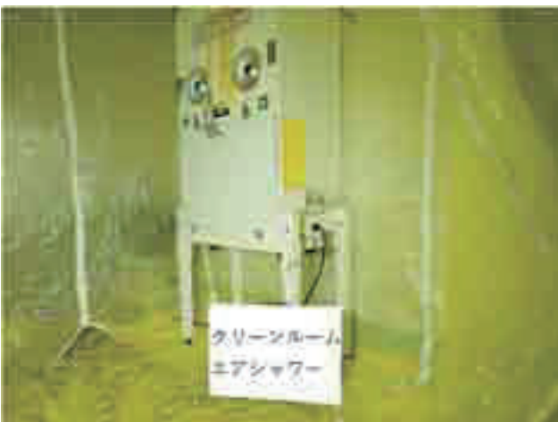
写真-7 クリーンルームの設置
