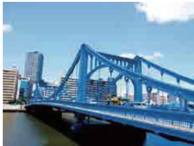
写真-2 清洲橋全景
