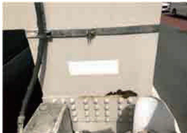
写真-4 剥離発生箇所の状況
