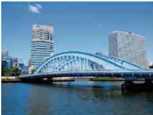
写真-1 永代橋全景
