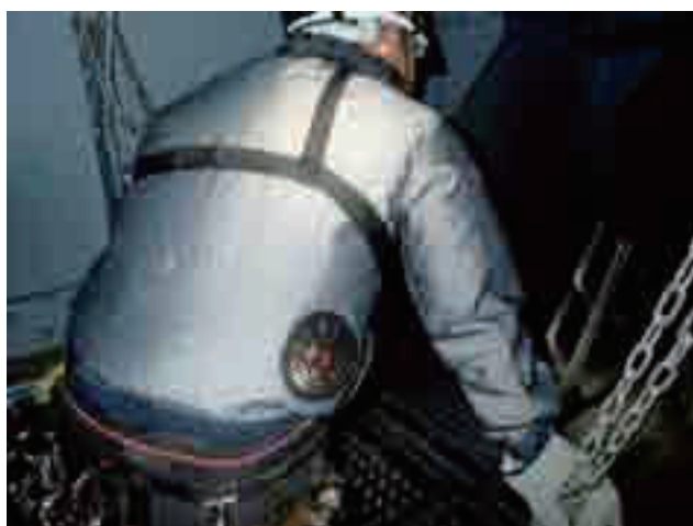
写真-12 熱中症対策③送風ファン付き作業服
