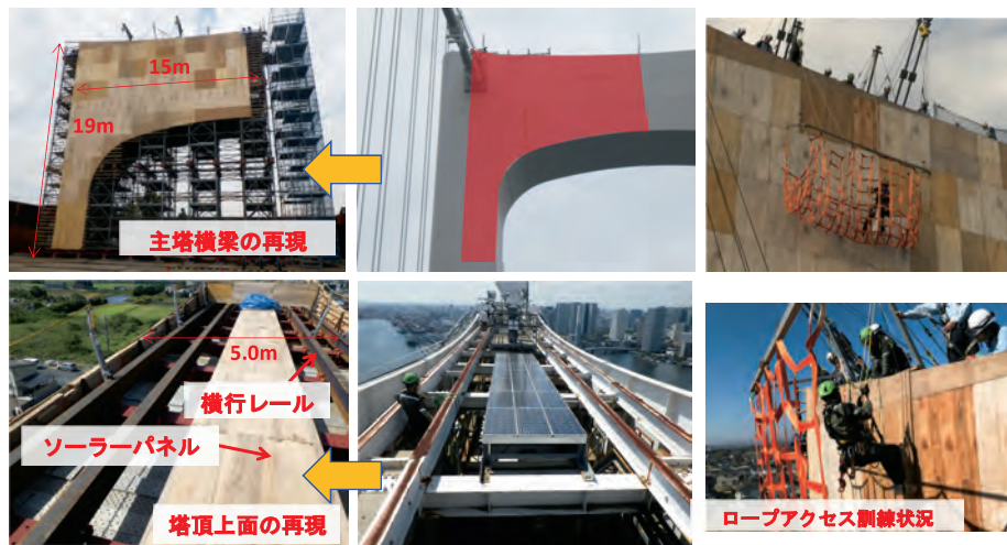
写真-5 実物大模型による実施工試験
