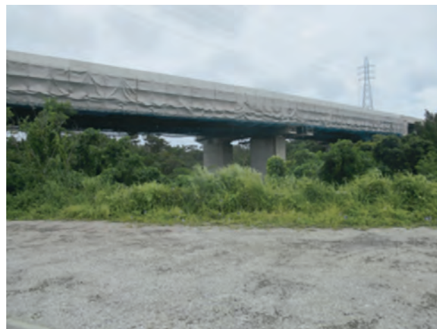
図-3 億首川橋全景写真
