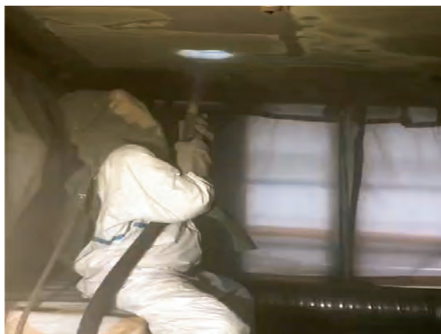
(a) 素地調整の状況
