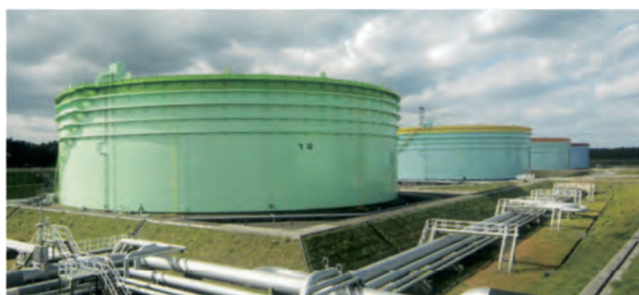
写真-4 国家石油備蓄基地のタンク群の一例
