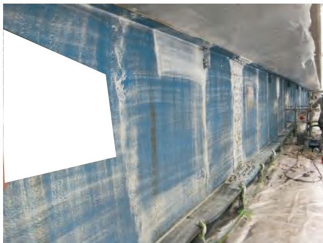
(a) 剥離剤工法による除去
