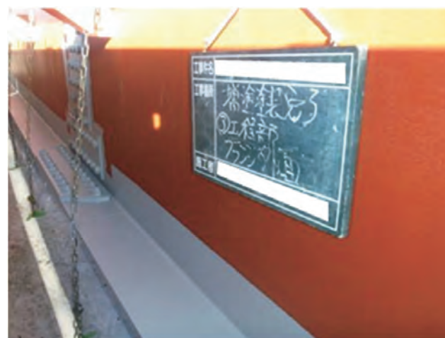
(b) 下フランジ上面の増し塗り
