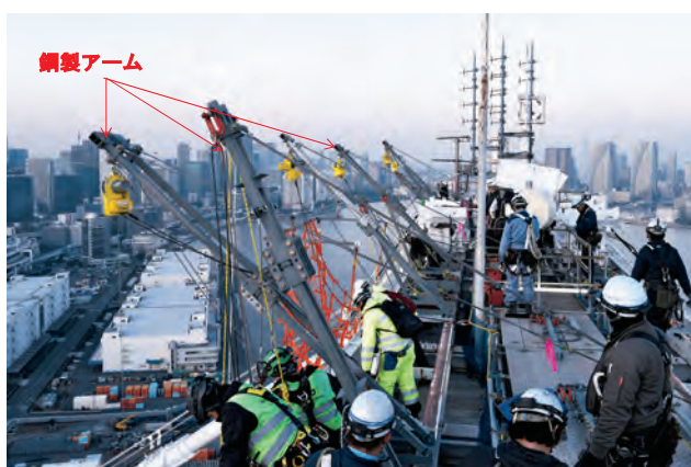
写真-8 塔頂上面における鋼製アーム設置状況
