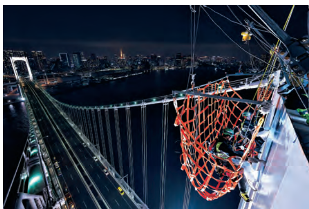
写真-10 ロープアクセス施工状況②
