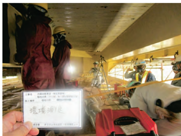
図-16 作業環境測定状況写真
