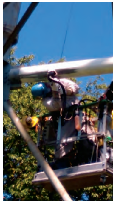
写真-8 ゴンドラ足場での塗装作業状況 16)
