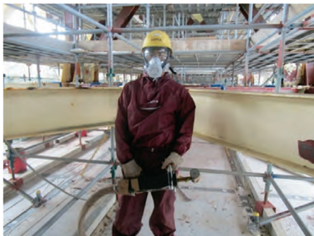
図-12 作業員の防護状況写真
