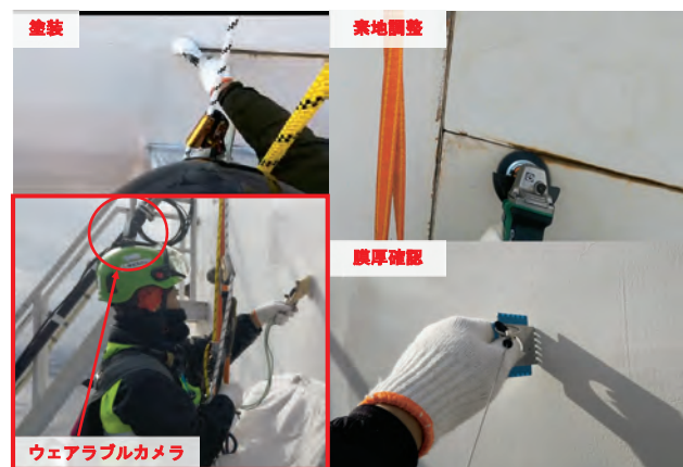
写真-7 ウェアラブルカメラによる品質管理状況
