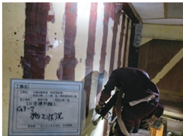
図-8 鋳桁施工状況
