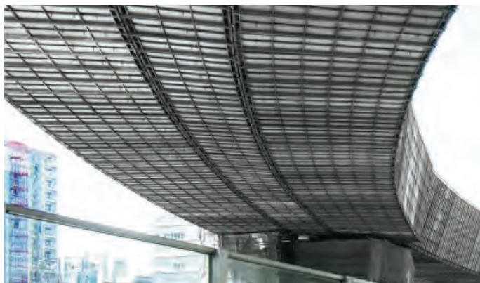
写真-2 閉塞化した足場防護の橋梁工事
