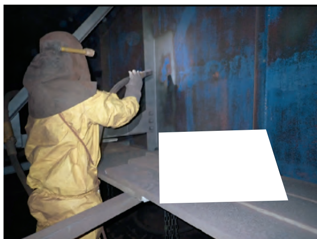
(b) ブラスト工法による除去
