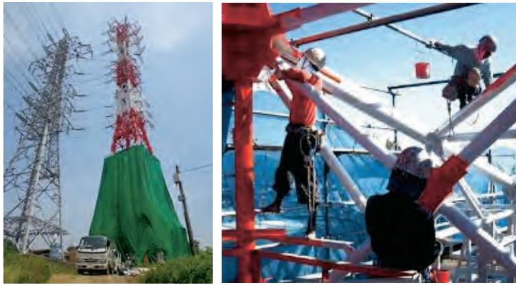
写真-7 養生した送電鉄塔と塗装作業状況
