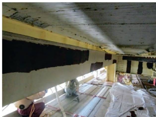
図-9 トラス上弦材施工状況
