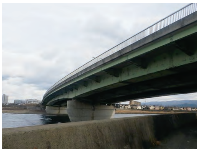
写真-3 泉南マリナブリッジ
