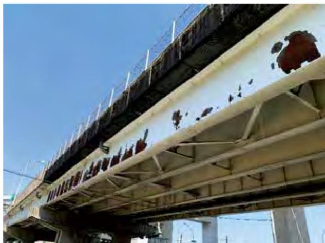
写真1 塗膜剥離の例
