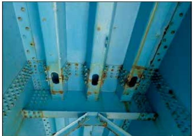
写真-1 橋梁の桁間の損傷状況例（県管理橋梁 M 橋）
