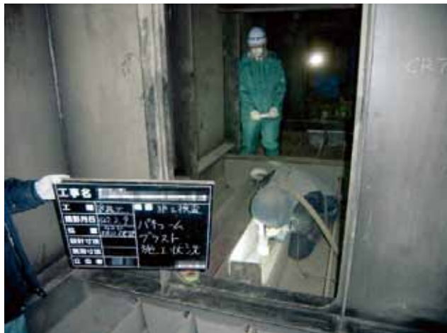
写真-15 ブラスト施工状況
