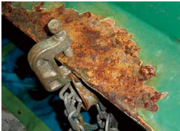
写真-8 足場クランプ部
