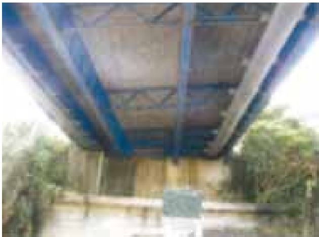
写真-1 SS橋 施工前
