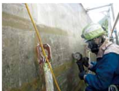
写真-8 ブリストルブラスター W 作業状況
