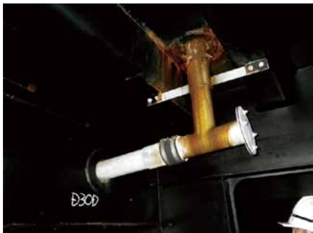
写真-11 箱桁内部の排水柵から漏水
