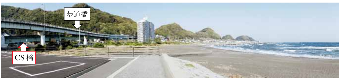
写真-3 CS橋 架橋環境
