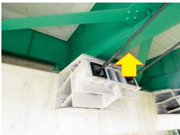
写真-10 モニタリングポイント外観 (施工後8ヵ月)
