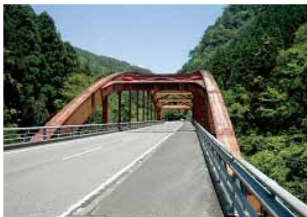
写真-1 親ヶ淵大橋
