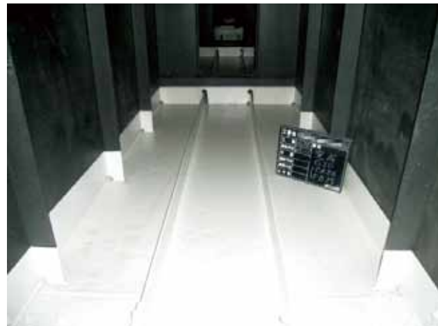
写真-16 塗装完了
