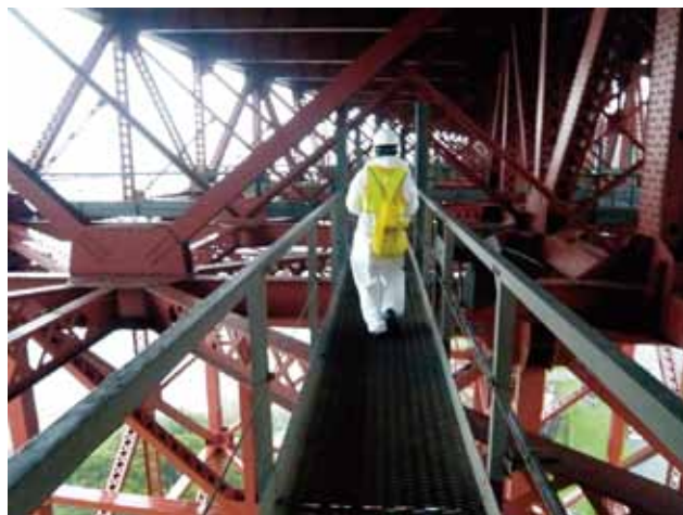
写真-6 橋梁内部
