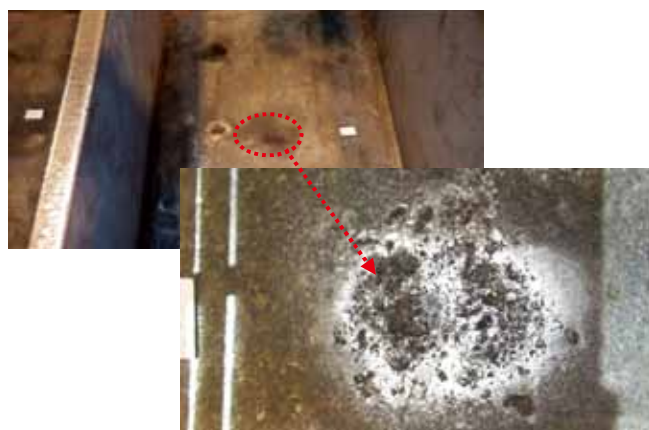
写真-14 2種ケレンの仕上がり状態 (2回目)
