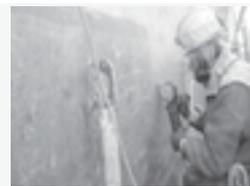
鉛、クロム、PCB等有害物含有塗膜を安全に剥離除去し且つ、塗替え塗装の耐久性を確保する素地調整1種相当を得る工法です。
