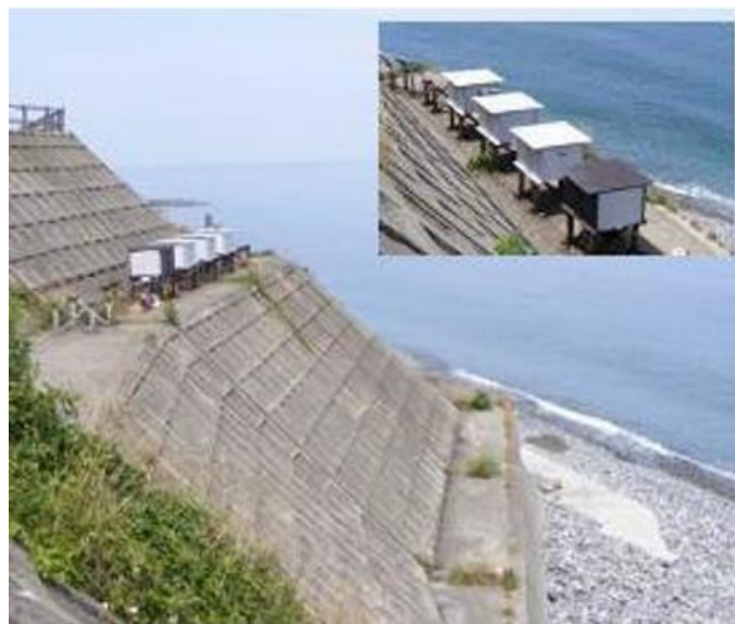
図 9 補修塗装試験体の暴露状況
