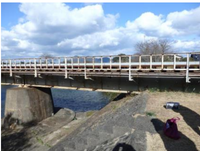
図 1 対象橋りょう（遠景）
