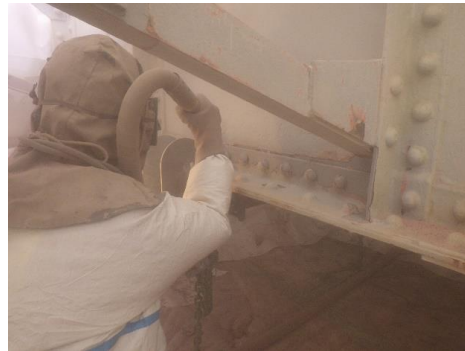
(b) 施工状況
