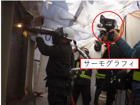
図 12 鋼材温度測定状況
