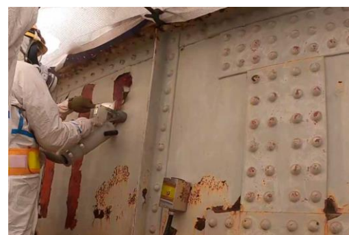
(b) 施工状況
