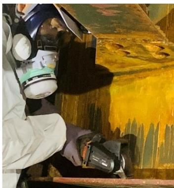
写真5 動力工具による素地調整状況
