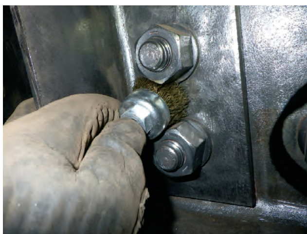
写真-2 素地調整（2種ケレン）状況 狭隙部、ボルト・ナット頭部の仕上げ
