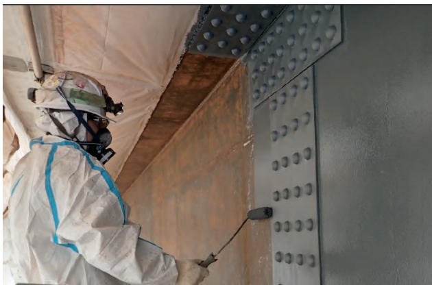
写真-6 防食下地の施工状況（ローラー）
