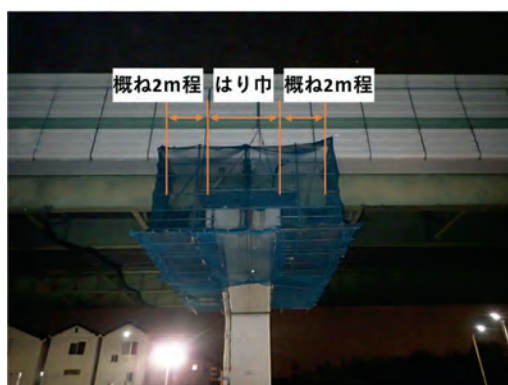
図-5 桁端部改良工の施工範囲イメージ図と足場架設事例
