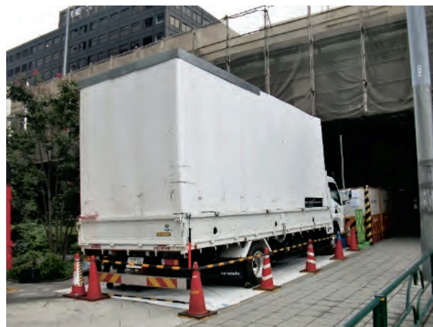
写真-2 循環式ブラスト後方設備設置状況
