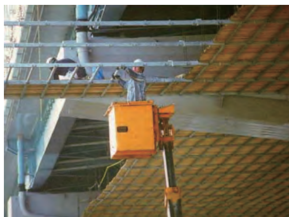
写真-5 GS足場 5) クランプの少ない構造を用いたシステム足場
