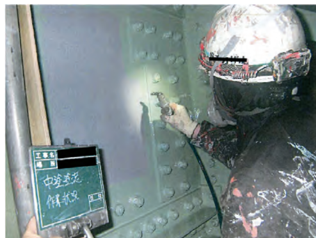
写真-4 中塗り状況（スプレー）
