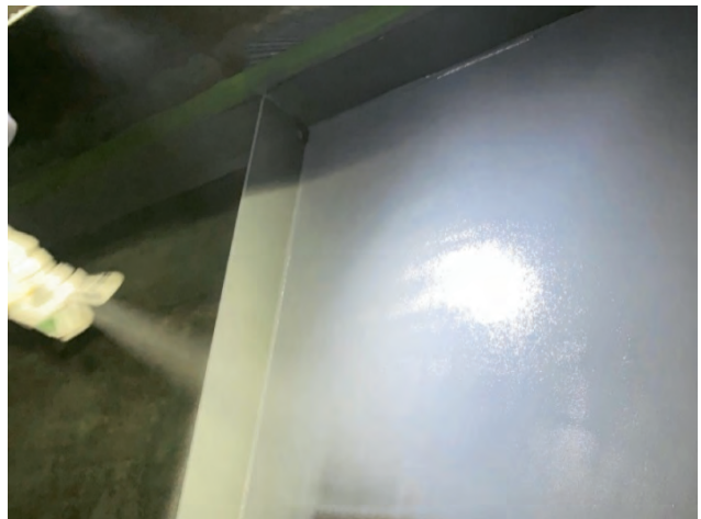
写真-5 防食下地の施工状況（吹付）
