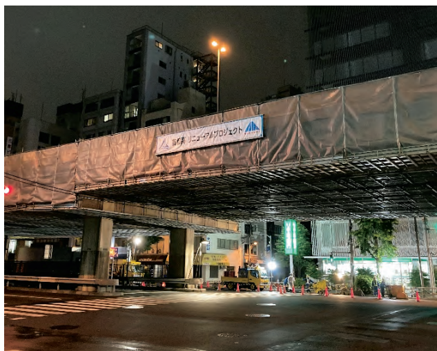
写真-1 塗装塗替えの足場設置状況
