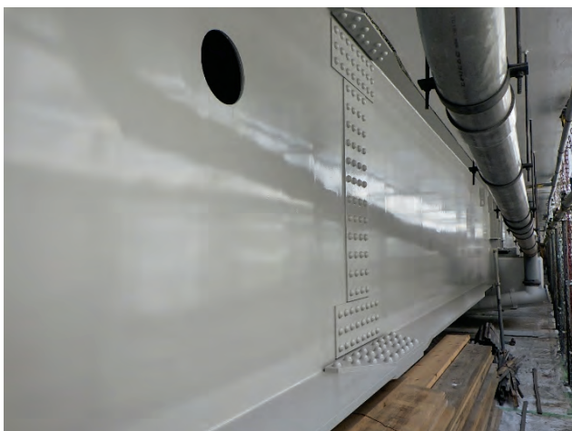
写真-8 塗替塗装完了状況（外桁）
