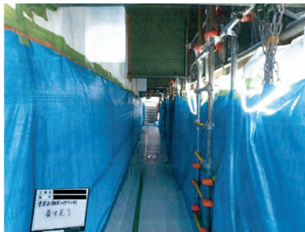
写真-6 飛散防止養生後の足場内状況
