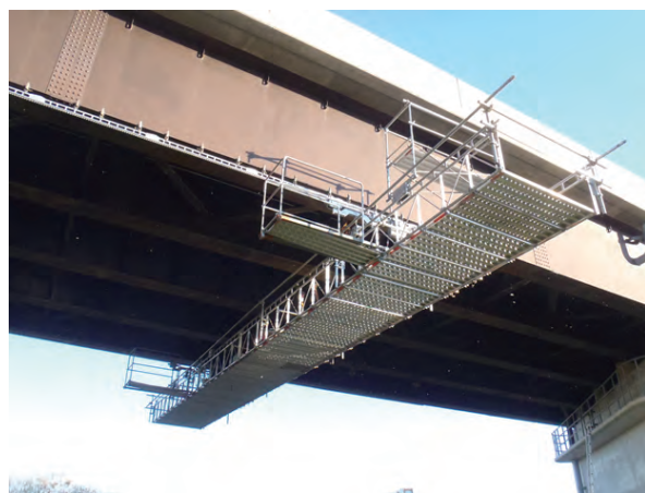
写真-2 ラック式吊足場 2) 2本のラックレールを軌道とする移動式吊足場
