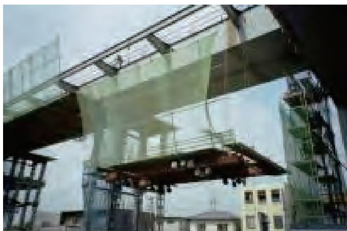
写真-3 パーフェクト足場 3) 吊上げ装置の上に足場を組み、まとめて吊上げる足場
