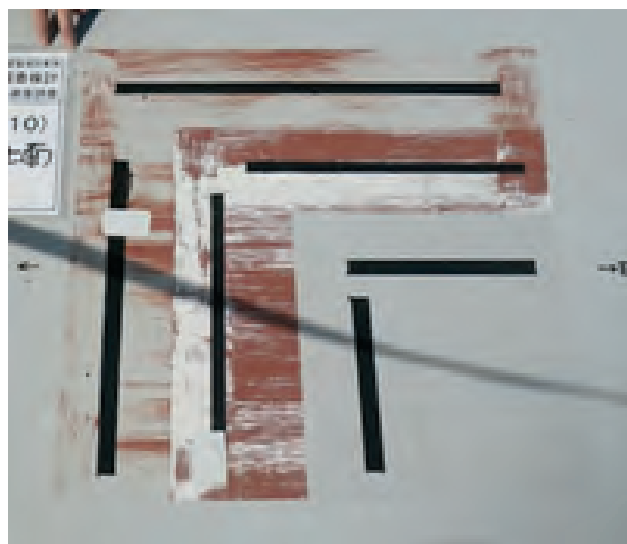
写真-5 上弦材上面 測定用定点 (下塗・中塗の経年による消失)
