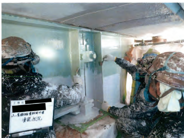
写真-3 中塗り状況（はけ塗り）
