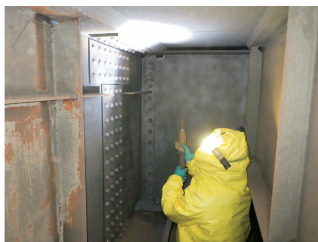
写真-3 循環式ブラスト施工状況
