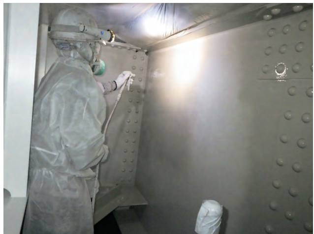
写真-7 上塗りの施工状況（吹付）
