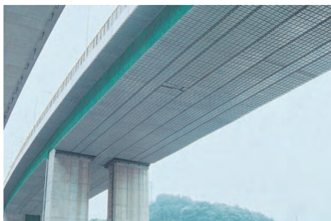
写真-4 SKパネル 4) 親パイプ・足場板等を一体化したパネル式吊足
