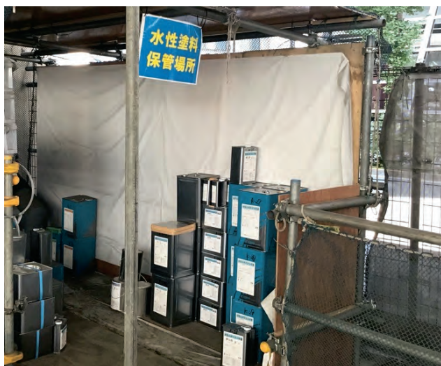
写真-10 水性塗料保管状況
