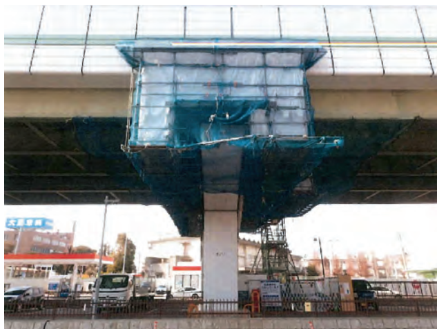
写真-5 飛散防止養生後の足場架設状況
