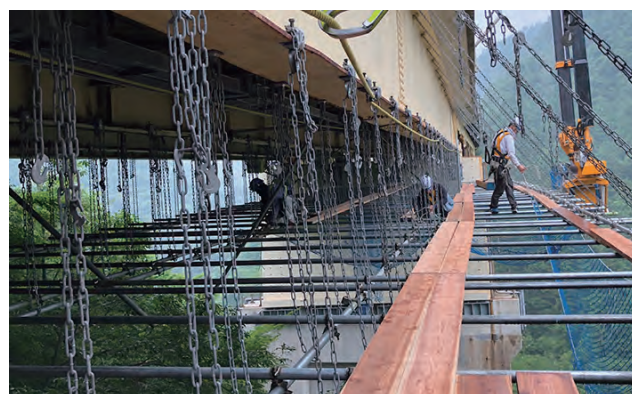
写真-1 単管吊足場 1)
