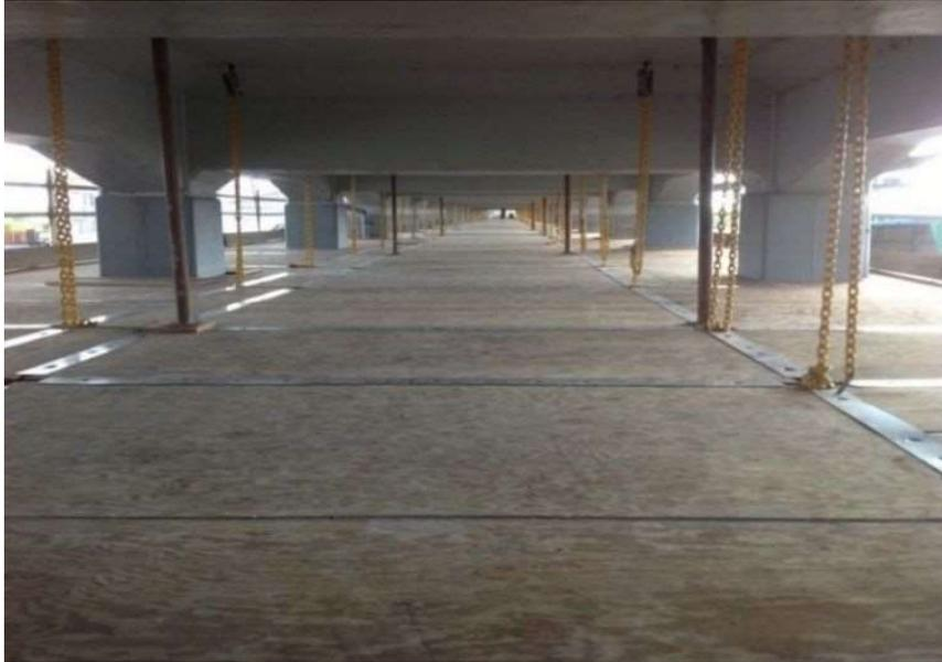
写真2 フロア型吊足場の現場設置状況
