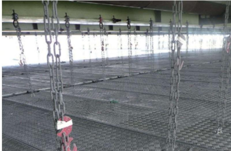
写真1 パネル式吊足場の現場設置状況
