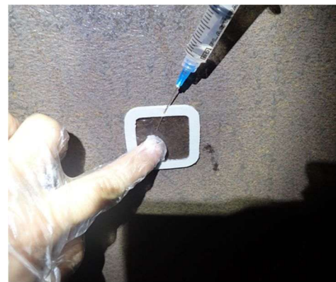
(b) 素地調整後の測定状況
