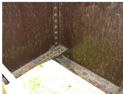
図 3 鋼素地の残留塩による塗膜下からの局部腐食の発生
