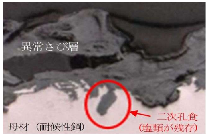
図 4 重度腐食部の断面
