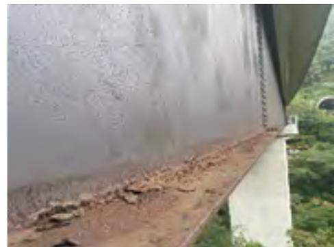
写真-6 毛細管現象によりウェブ立上り部に生じた水染み跡
