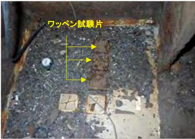
写真-2 池-1114 内桁 下 flg 上面の腐食環境
