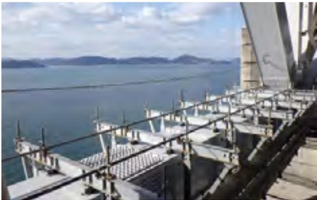
写真-3 足場設置用架台 (水平部)
