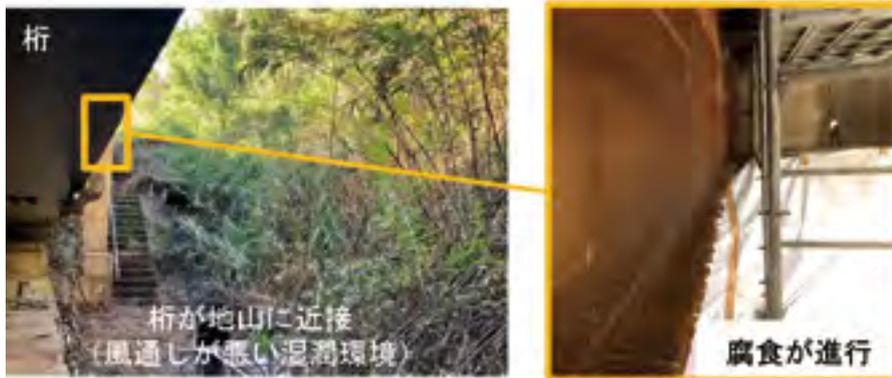
写真-5 桁端部の腐食事例
