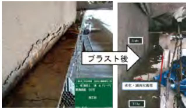
写真-4 重度腐食により母材が消失した事例
