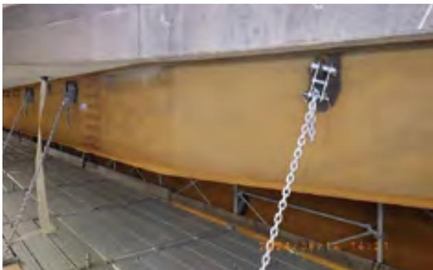
写真-9 水由来の薄い黄・赤褐色の戻りさび
