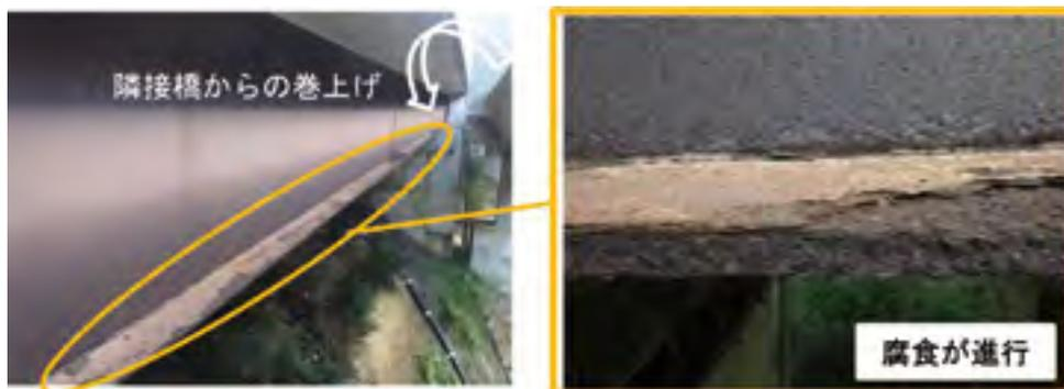
写真-7 隣接橋からの凍結防止剤の影響による腐食事例
