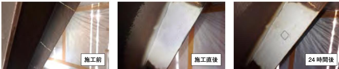
写真-13 AWT工法による素地調整前後の鋼素地の状況<sup>4)</sup>
