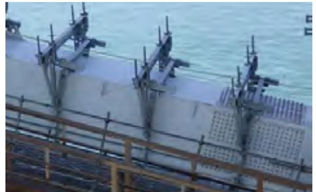
写真-4 傾斜部用の架台設置完了
