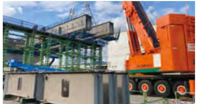
写真-2 主桁の地組と架設状況
