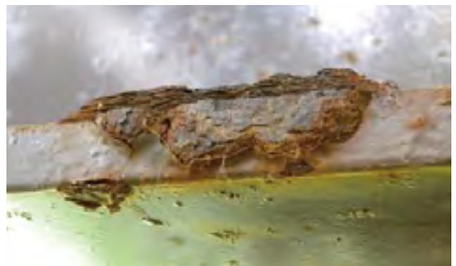
写真-3 残留塩による塗膜下からの局部腐食<sup>3)</sup>
