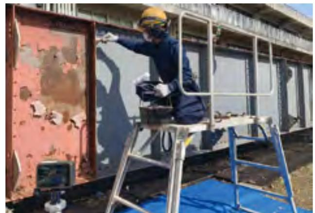
写真-3 塗装作業性の評価試験状況
