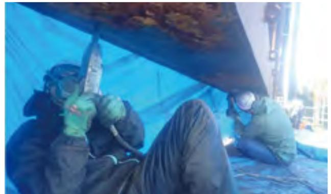
写真-2 チッピング処理
