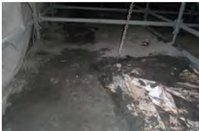
写真-11 素地調整後の清掃が不十分な例
