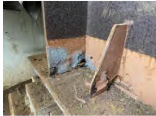
写真-8 塗膜下腐食による再劣化の事例
